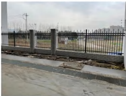
车辆基地立柱+铁艺栏杆+绿化带
