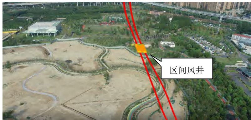
图 2.1-4 区间风井周边现状照片
