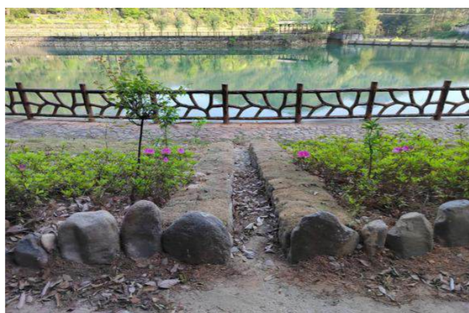
滨水护岸建设
