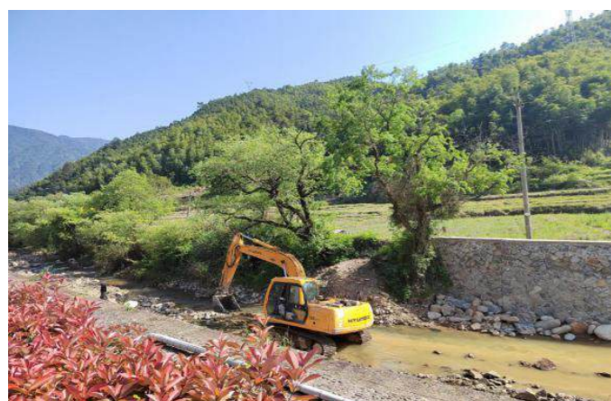
河道清淤工程
