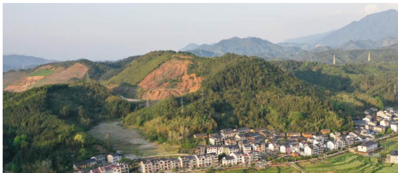
现状矿山情况
