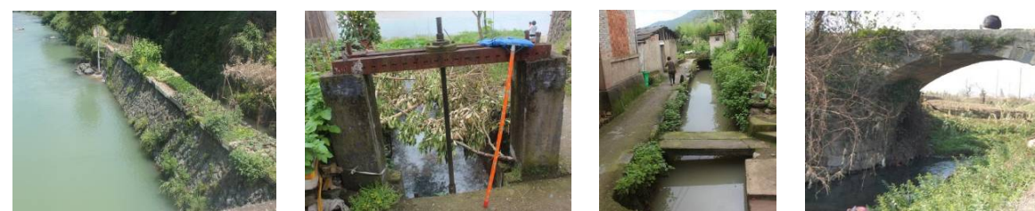
渠首 闸坝 圳道 桥梁
