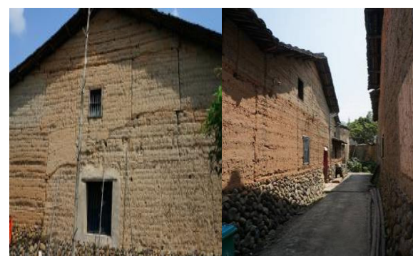
图21 大窑村版筑夯土墙
