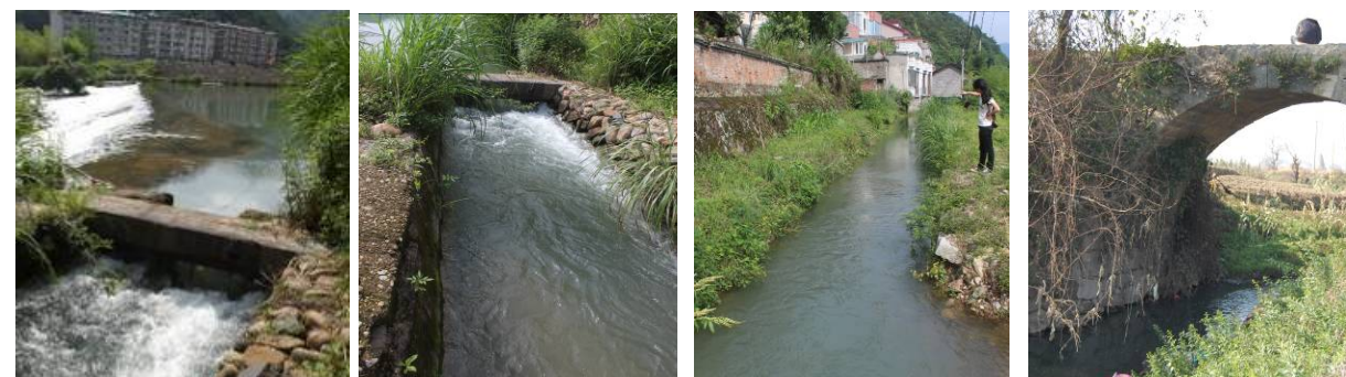
图61 云水渠引水口及云水渠出水口
