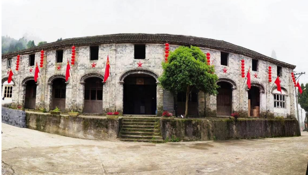
万山地下交通总站
