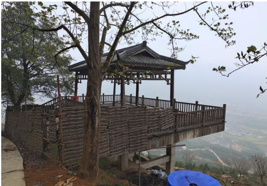
观云台木质结构老化
