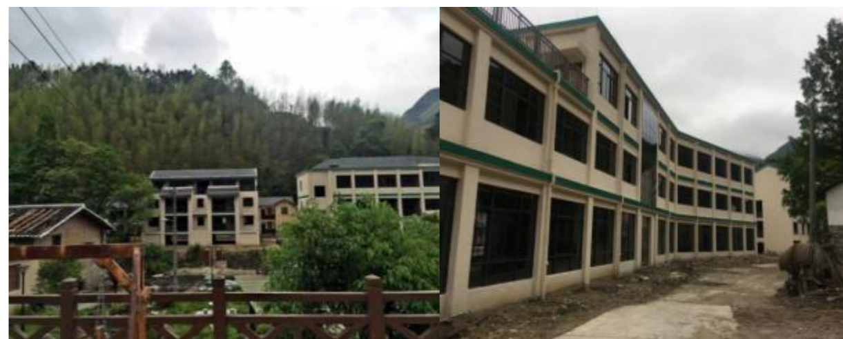
图 2 永青林场管护房现状图
