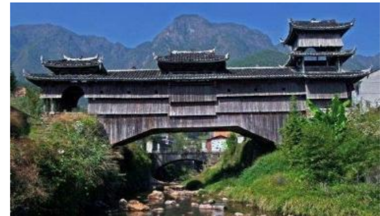
图 9 如龙桥（木拱廊桥）
