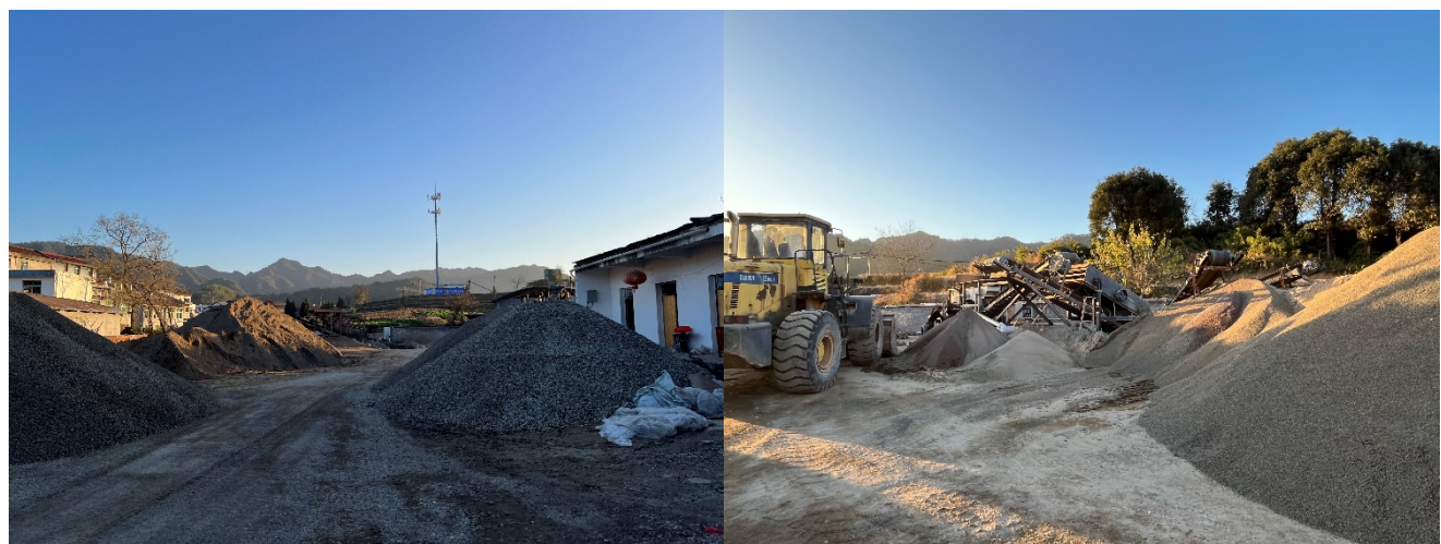
图 3-2 浙江光实建材有限公司建筑垃圾处理场现状
