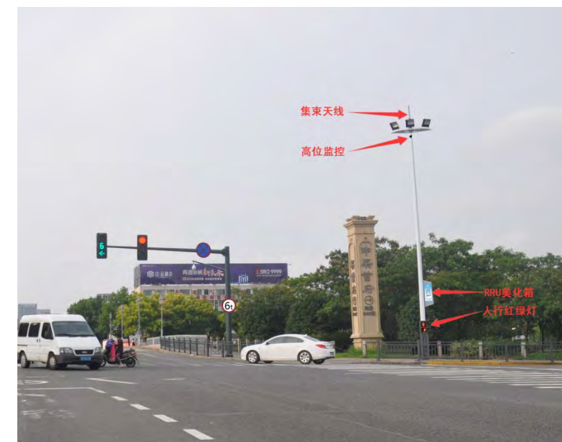
图 8-6 高杆，RRU 上塔
