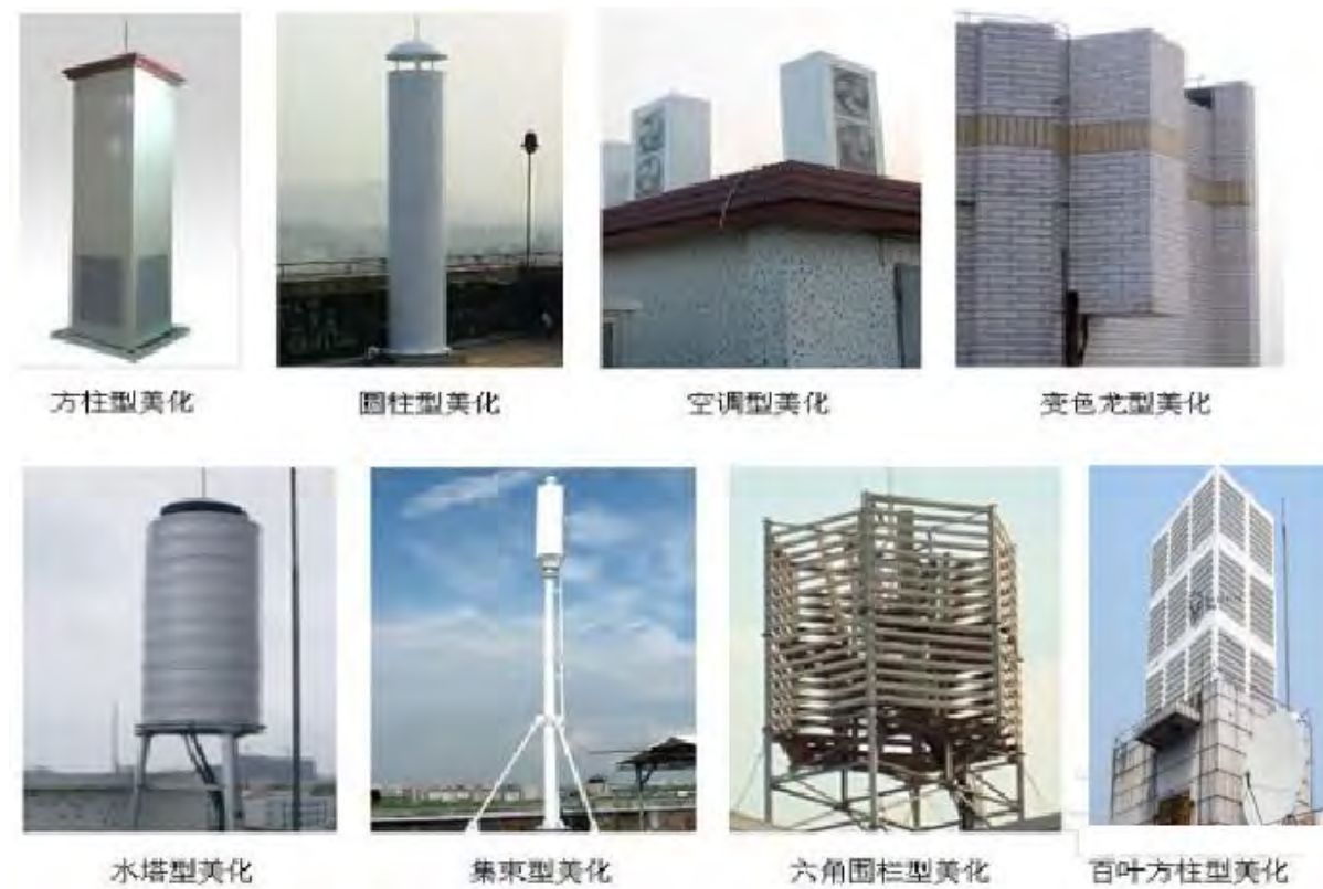
图 8-2 楼顶美化基站天线示意图
