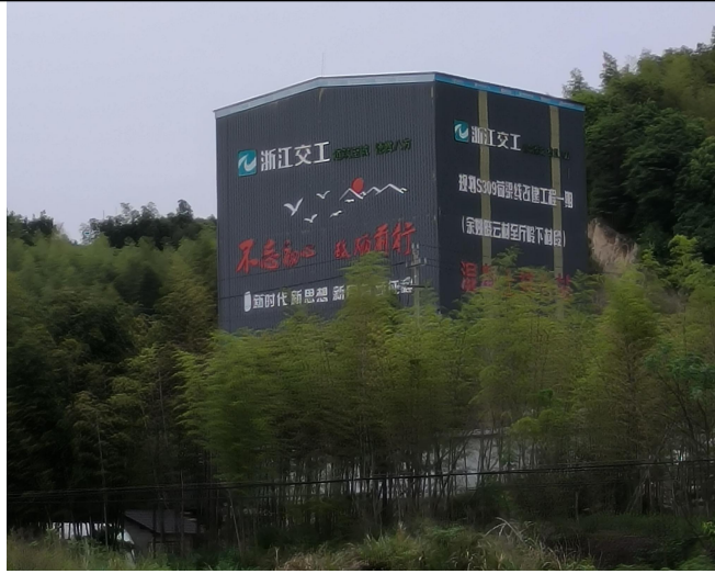
图 2-10 荷梁线一期工程拌合站厂房图
