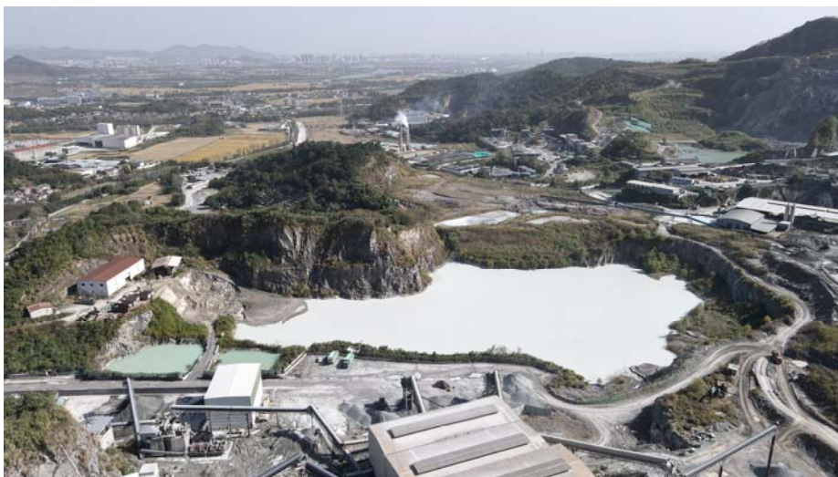
照片 1—5 矿区东侧沉淀池设施
