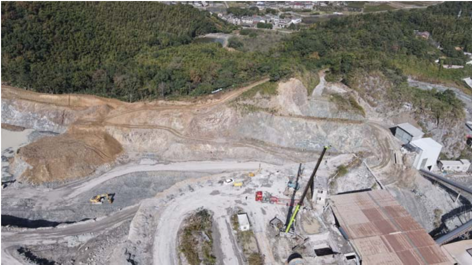
照片 3-4 D 段现状边坡
