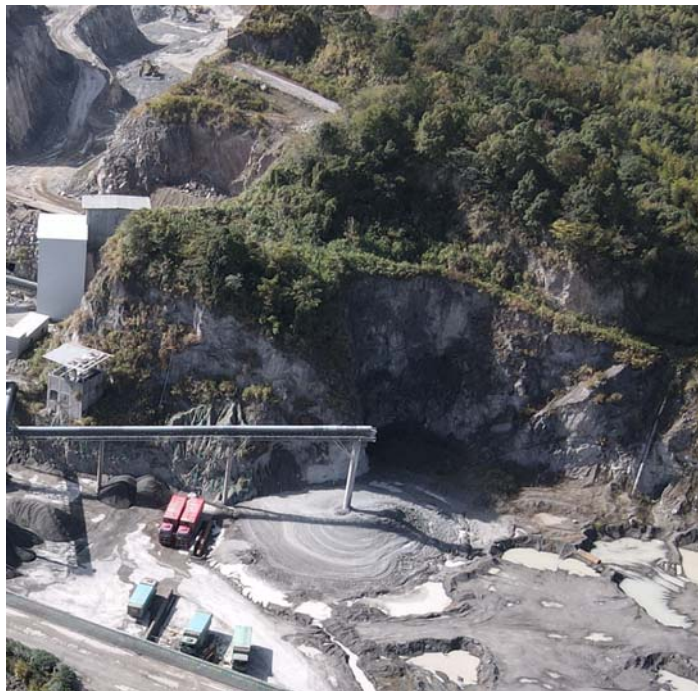
照片 3—4 E 段现状边坡
