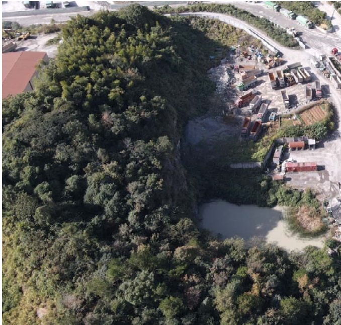
照片 3—6 G 段现状边坡
