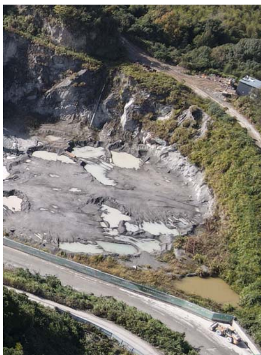
照片 3—5 F 段现状边坡
