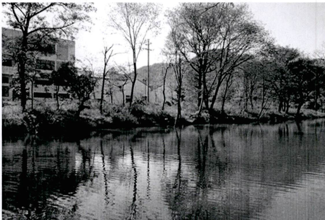
图5—李溪河道水生态治理整治段
