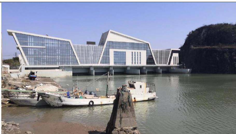
图 3-8c 工程海域附近水利设施（胡陈港水闸）
