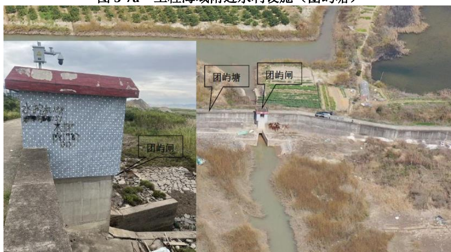
图 3-7b 工程海域附近水利设施（团屿闸）
