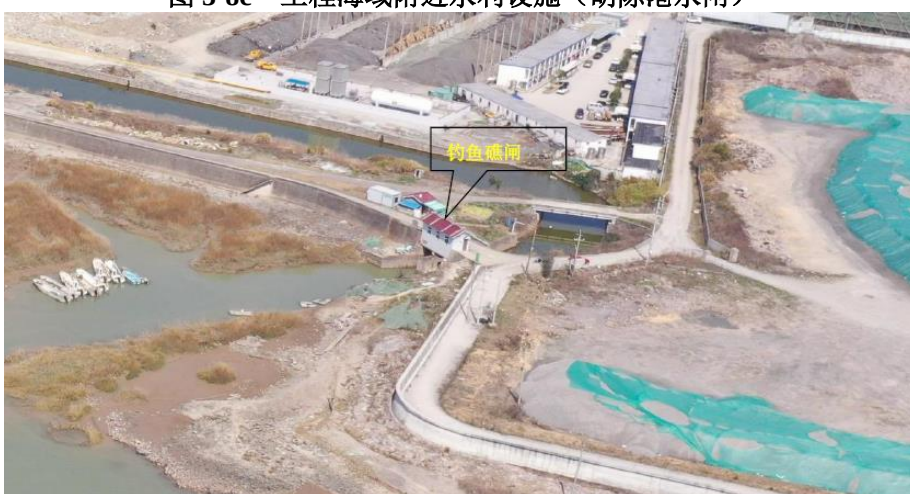
图 3-8d 工程海域附近水利设施（钓鱼礁闸）
