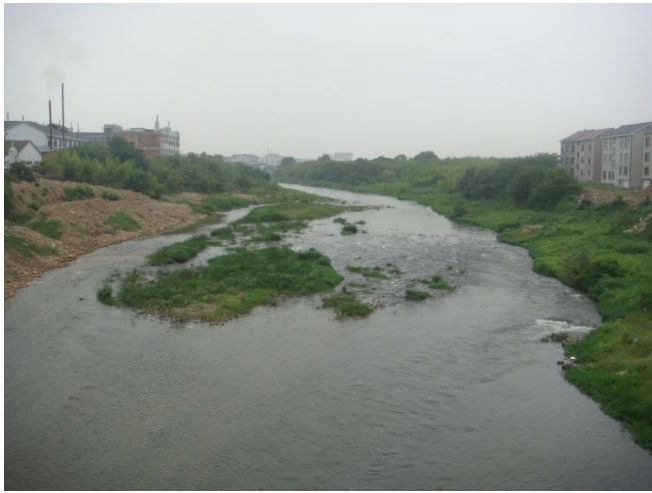
友谊大桥上河道
