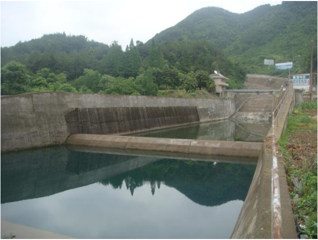
横锦水库溢洪道滚水坝
