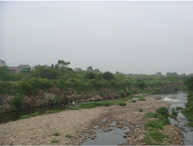
长征大桥下河道
