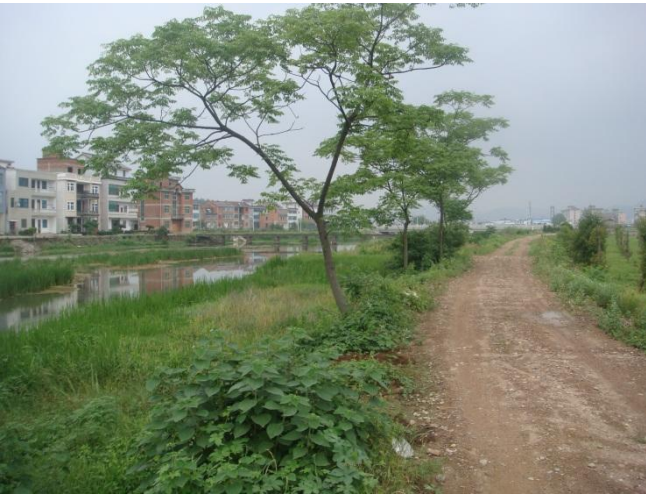
金塘圳老桥段右岸堤防
