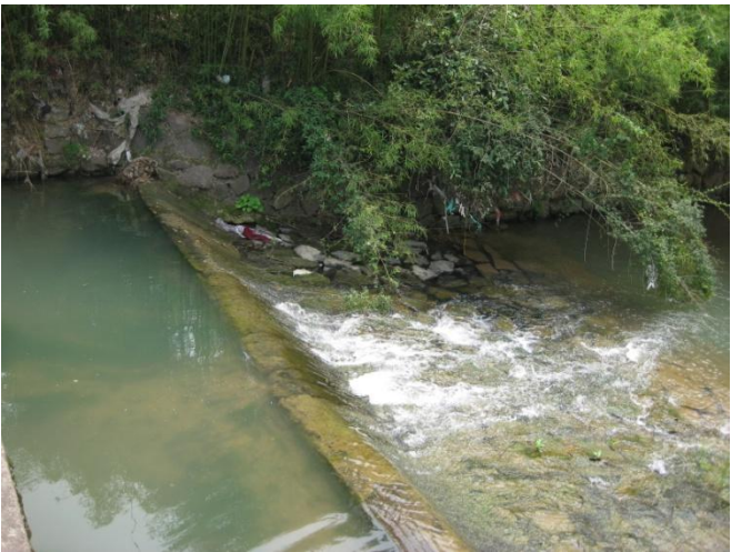
楼梯瓣桥下堰
