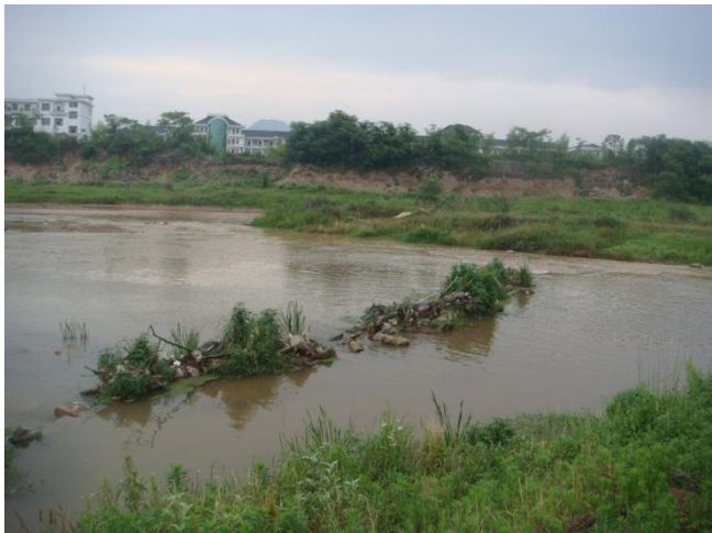
白溪汇合口段河道
