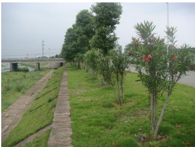
歌山公路桥段右岸堤防
