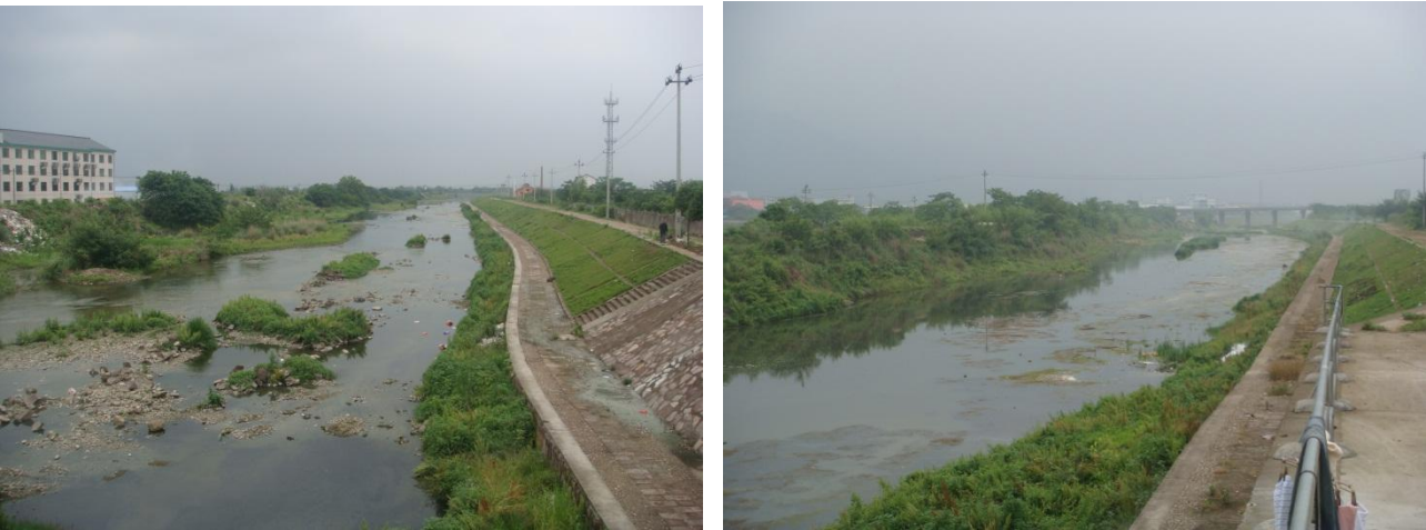
歌山公路桥下游左岸堤防（左）
