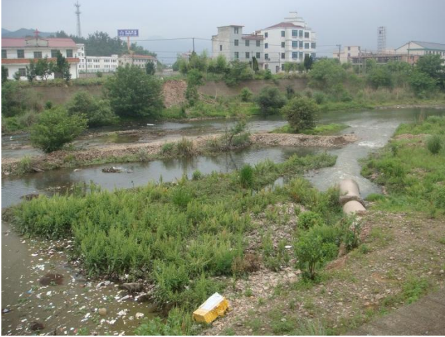
歌山公路桥处河道
