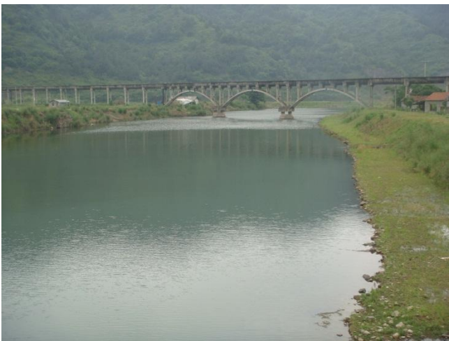
横锦水库供水渡槽段堤防和河道
