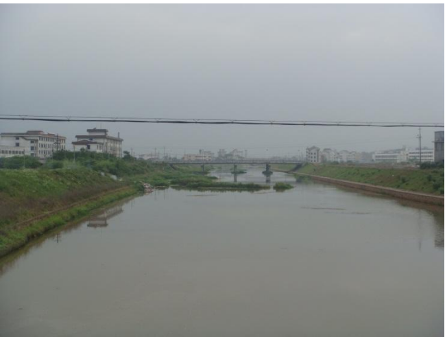
香娟桥段左岸堤防（左）
