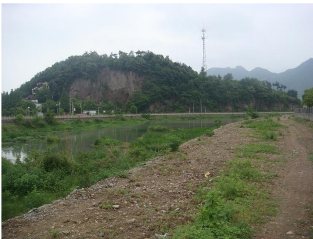
三甲院桥下游右岸堤防
