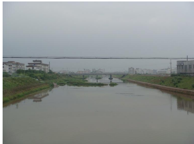
香娟桥段右岸堤防（右）
