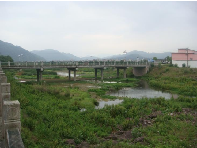
上陈大桥处河道
