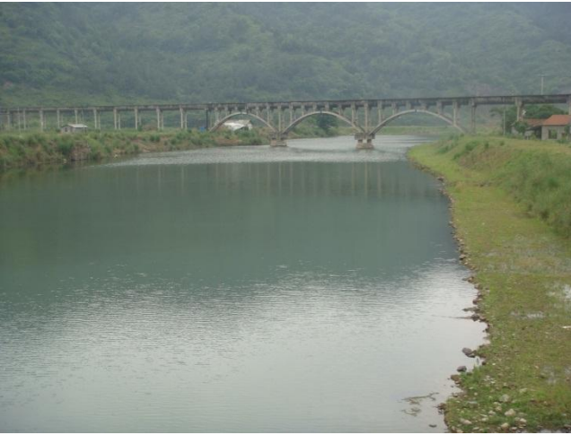
横锦水库渡槽处河道
