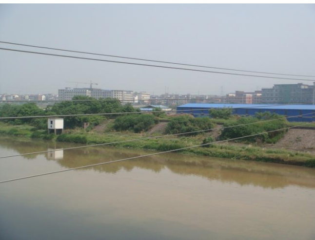
山口大桥段右岸堤防
