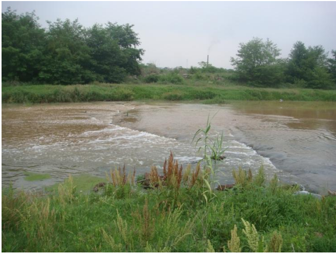
与白溪汇合口上游右岸堤防
