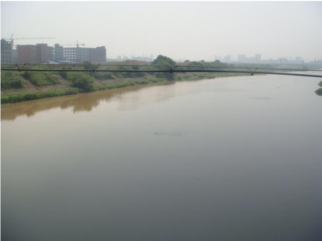
山口大桥段左岸堤防
