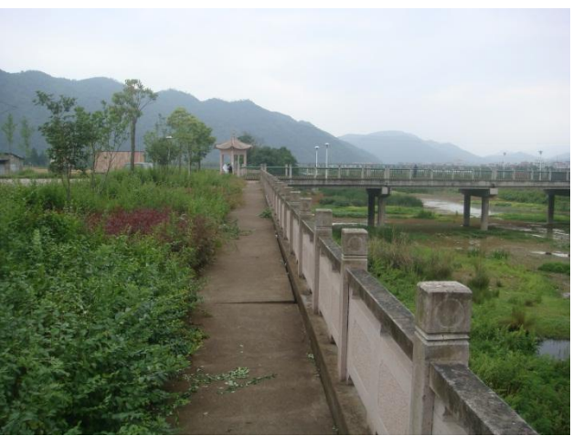
上陈大桥上游左岸
