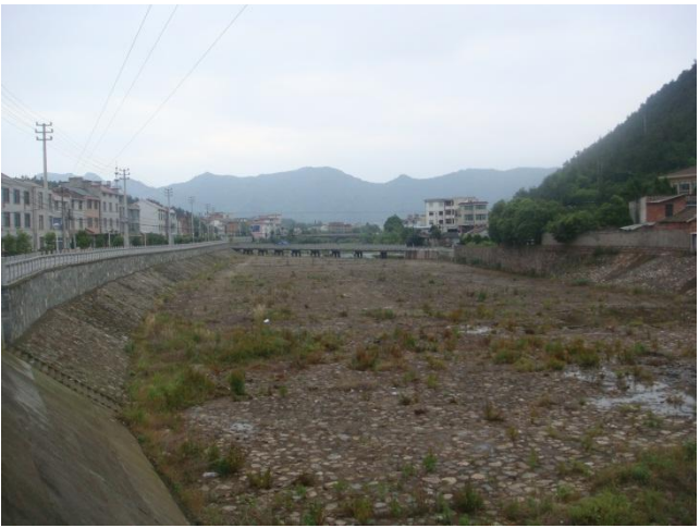
溢洪道滚水坝下游河道
