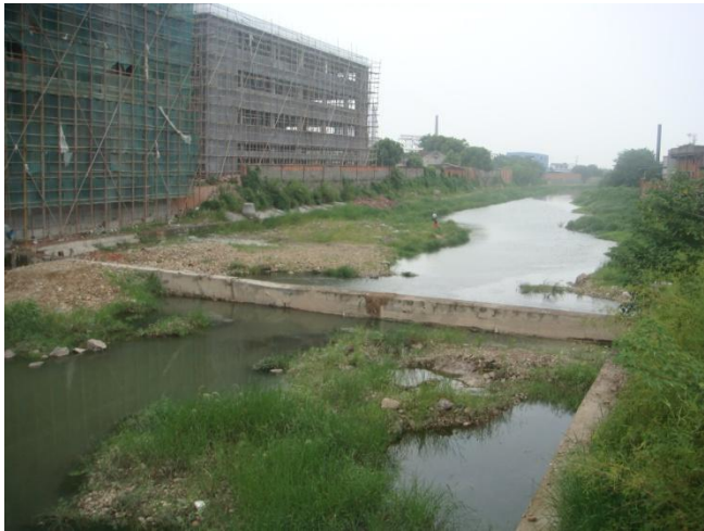
化工厂桥下堰
