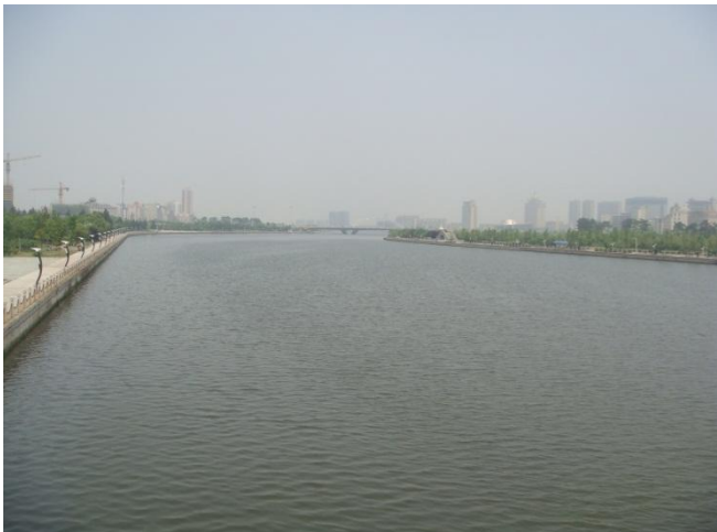
艺海大桥处河道
