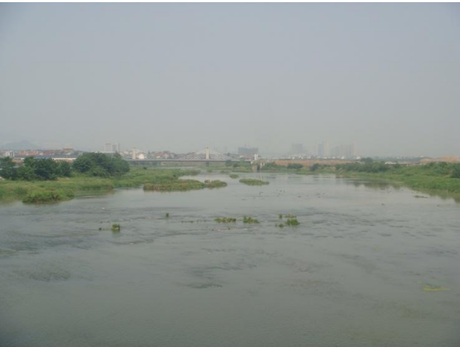
水豆大桥段堤防
