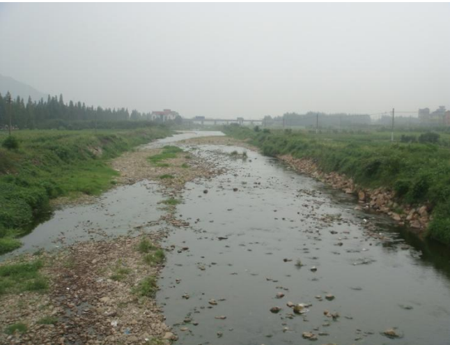
周村大桥下河道
