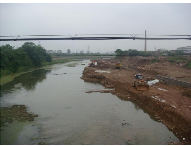
与白溪汇合口上游右岸在建段堤防
