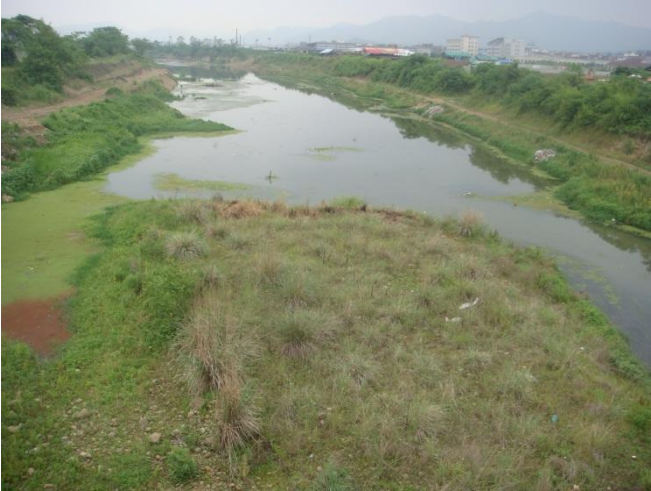
上蒋大桥段左岸堤防（左）
