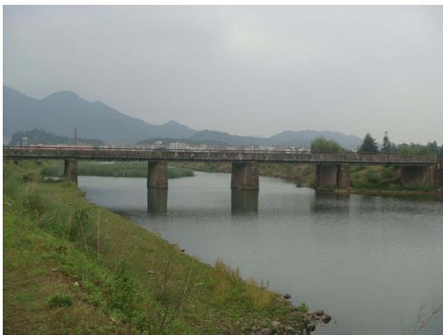
西山干大桥河道和堤防
