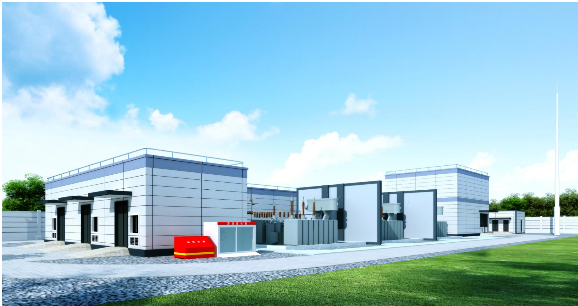
110kV 万国变西北视角透视图
