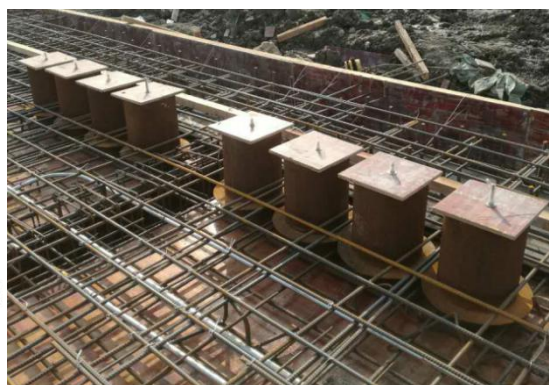
图 46 采用螺杆固定
