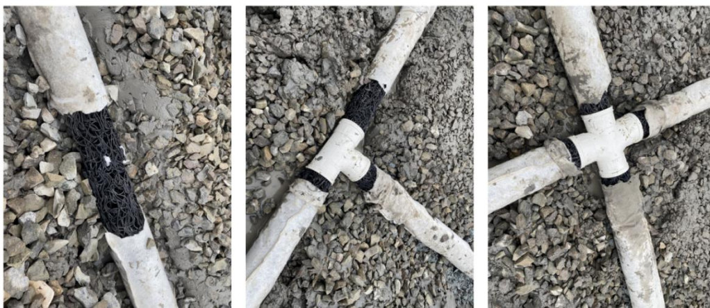
图 4 塑料盲管各转折点连接实景图
