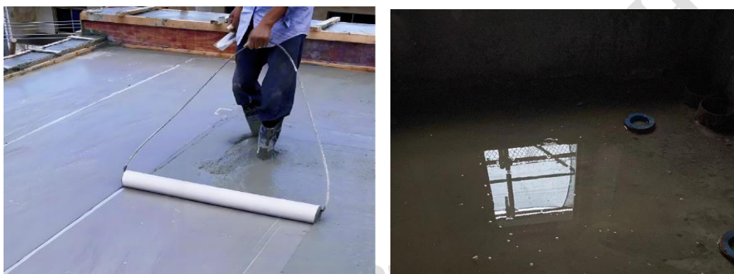
图 49 覆盖薄膜和蓄水养护
