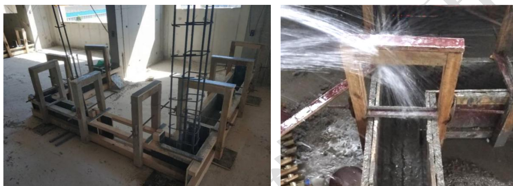
图 33 定型化夹具加固，反坎浇筑前充分冲洗干净
