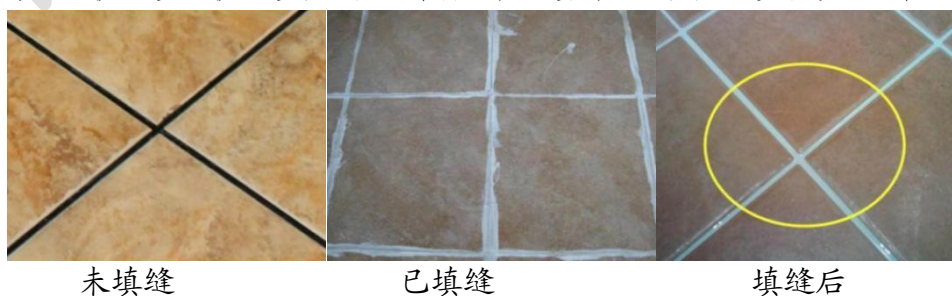
图 42 接缝采用填缝剂处理
