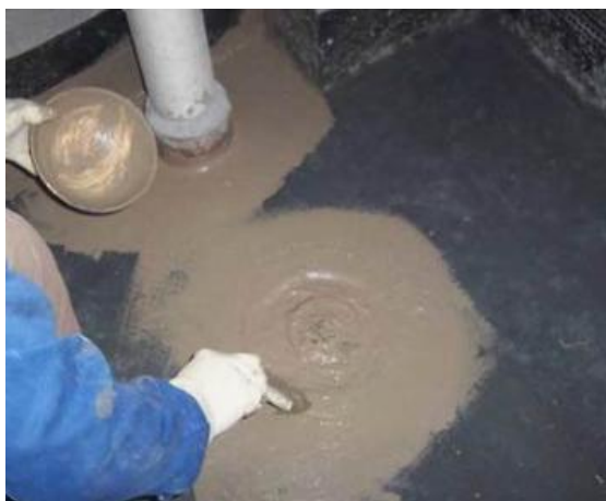
图 47 采用分层封堵
