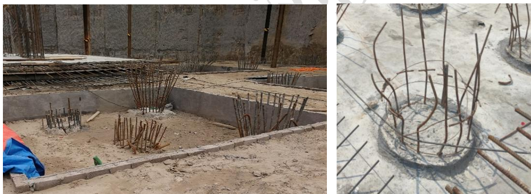
图 8 钢筋笼定位不准
