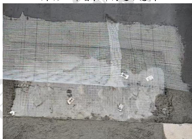
图 80 外墙粉刷构造
