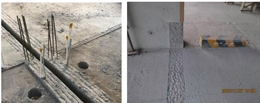
图 32 墙体砌筑前凿毛处理
