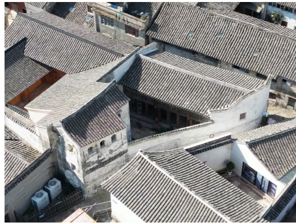
从东向西鸟瞰建筑整体
