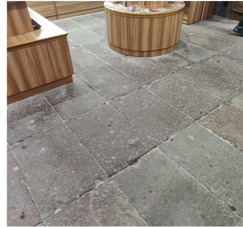
室内老石板铺地
