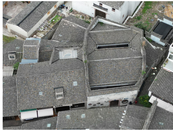
自南向北鸟瞰建筑整体
