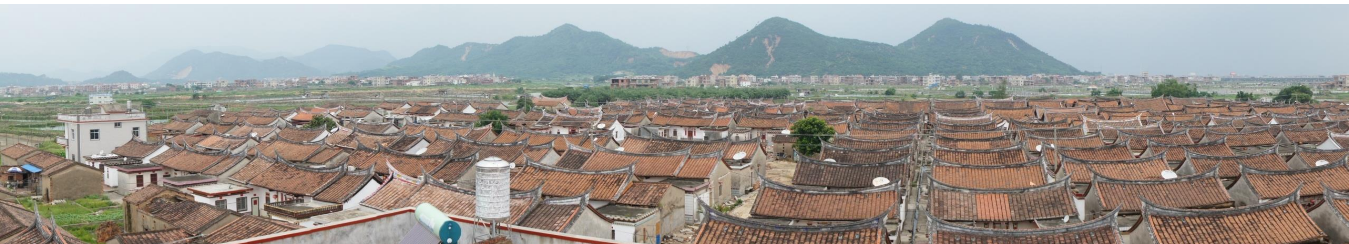
一层行列式建筑布局——福建漳州市埭美村现状照片
