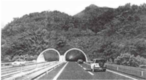
穿山半岛白洋线工程
