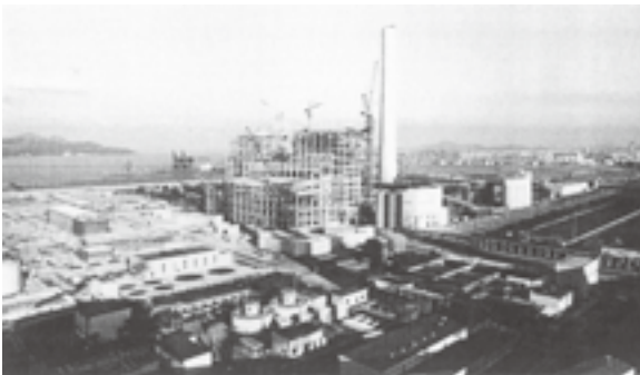
建设中的国电北仑三期工程（2007 年 10 月）
