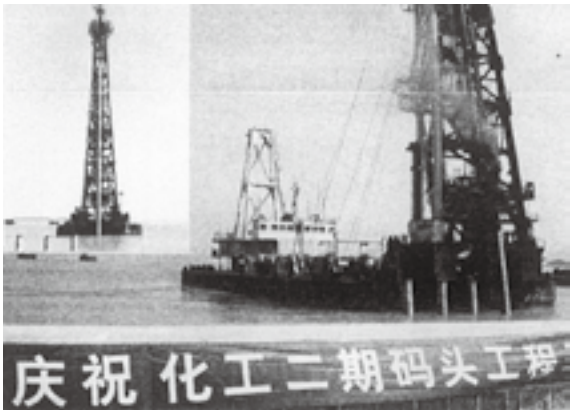
9 月 28 日，宁波开发区青峙化工码头二期工程开工
