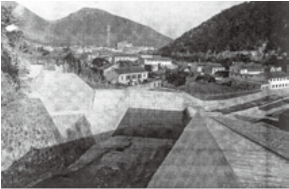
城湾水库溢洪道改造工程
