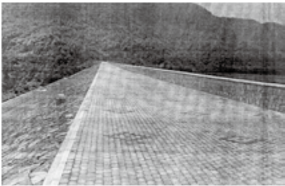
新路岙水库加固工程
