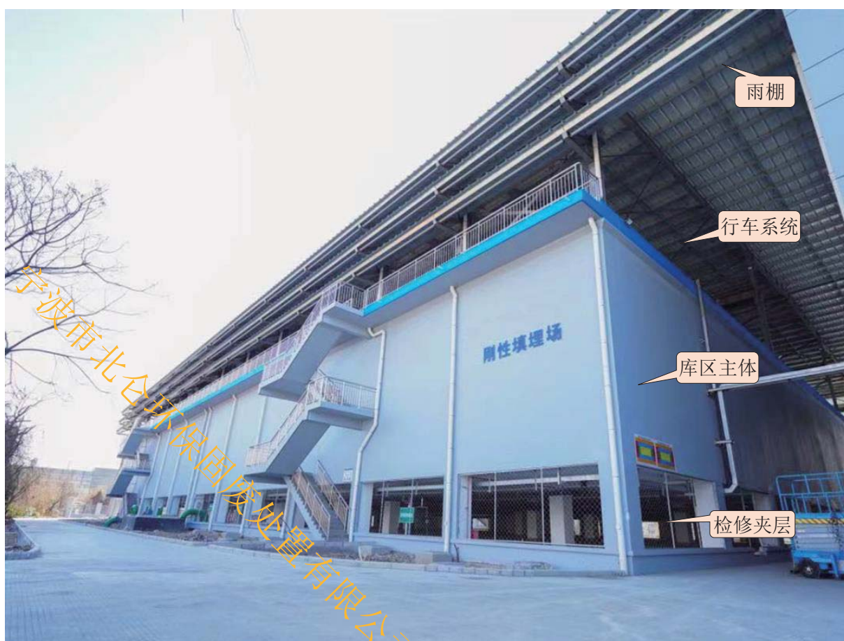
图 4.7-4 与本项目类似的浙江省已建成的同类刚性填埋场样图
