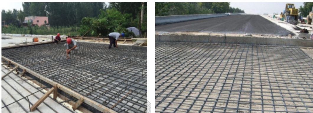
图 5-39 搭板钢筋绑扎
