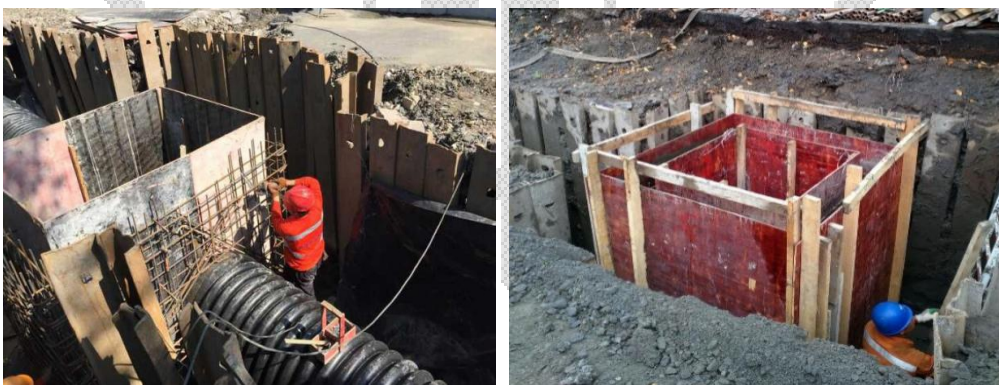
图 5-13 混凝土检查井施工
