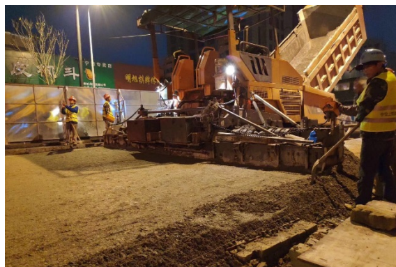
图 5-19 水泥稳定层摊铺施工示意图
