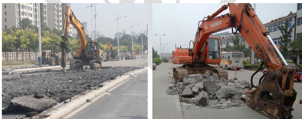
图 5-9 混凝土路面拆除工程施工示意图
