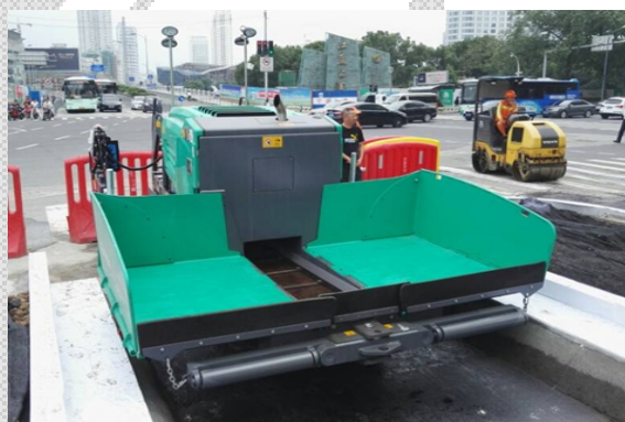
图 5-27 小型摊铺机摊铺非机动车道
