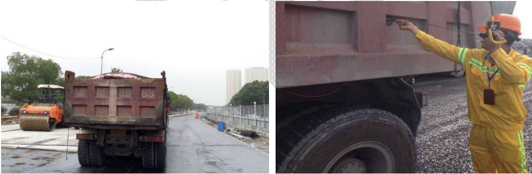
图 5-25 混合料到场及温度检测
