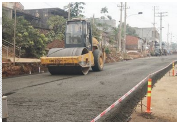
图 5-20 水泥稳定层碾压施工图
