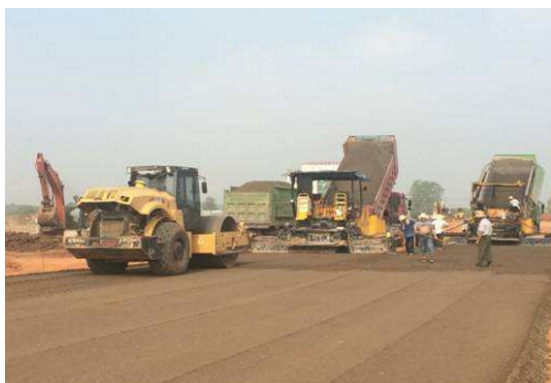
图 5-19 水泥稳定层摊铺施工示意图
