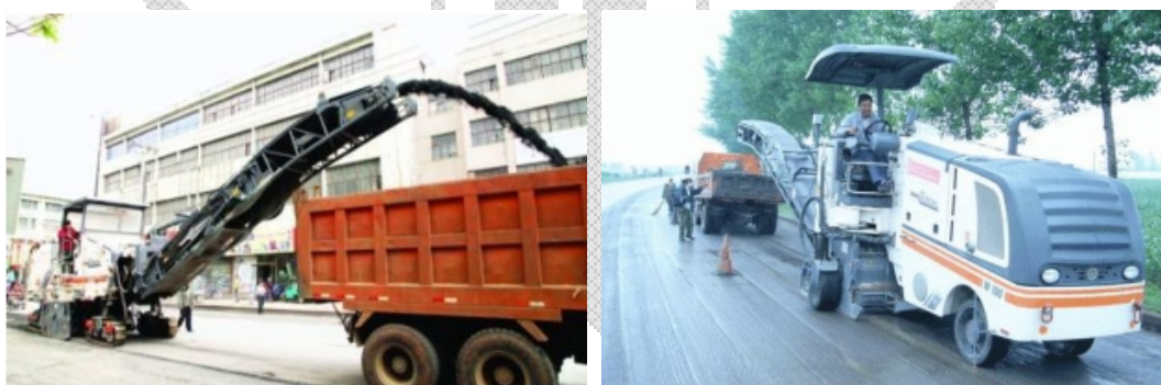
图 5-10 沥青路面铣刨示意图
