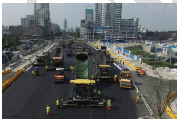
图 5-26 摊铺施工示意图
