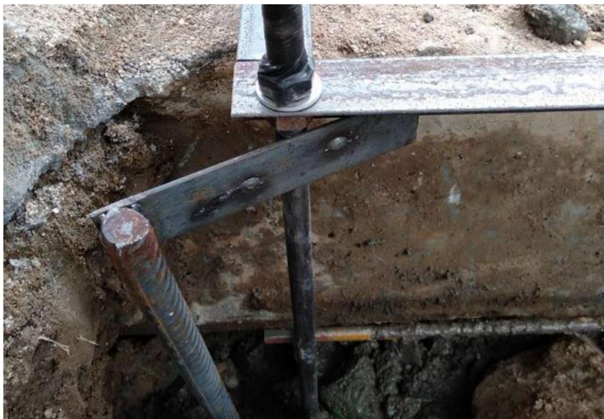
接地棒连接（示意图）
