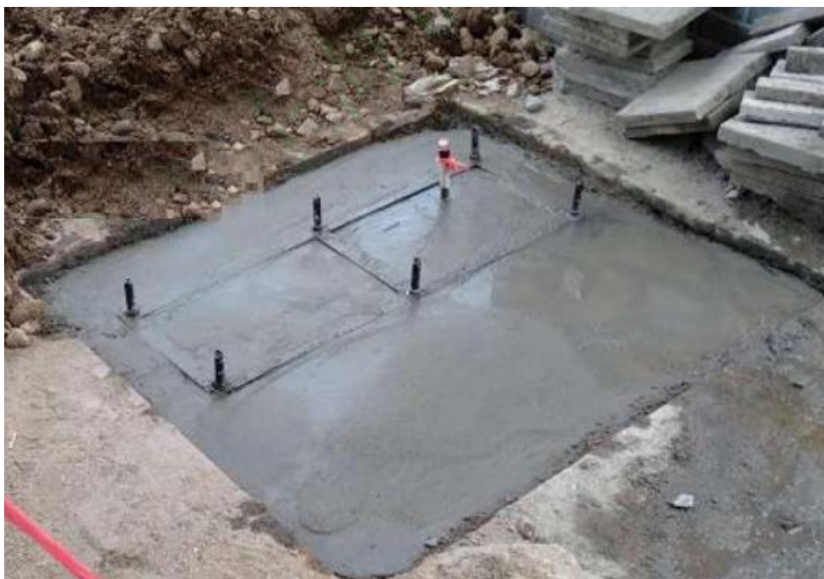
混凝土浇筑完成并平整（示意图）
