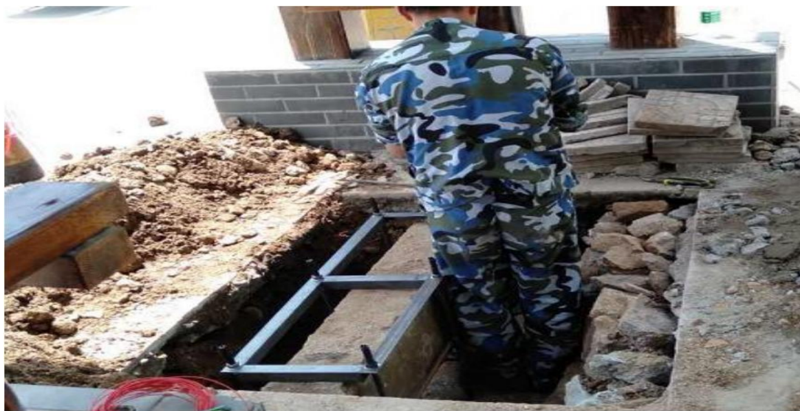
预埋件放置，保护螺纹（示意图）
