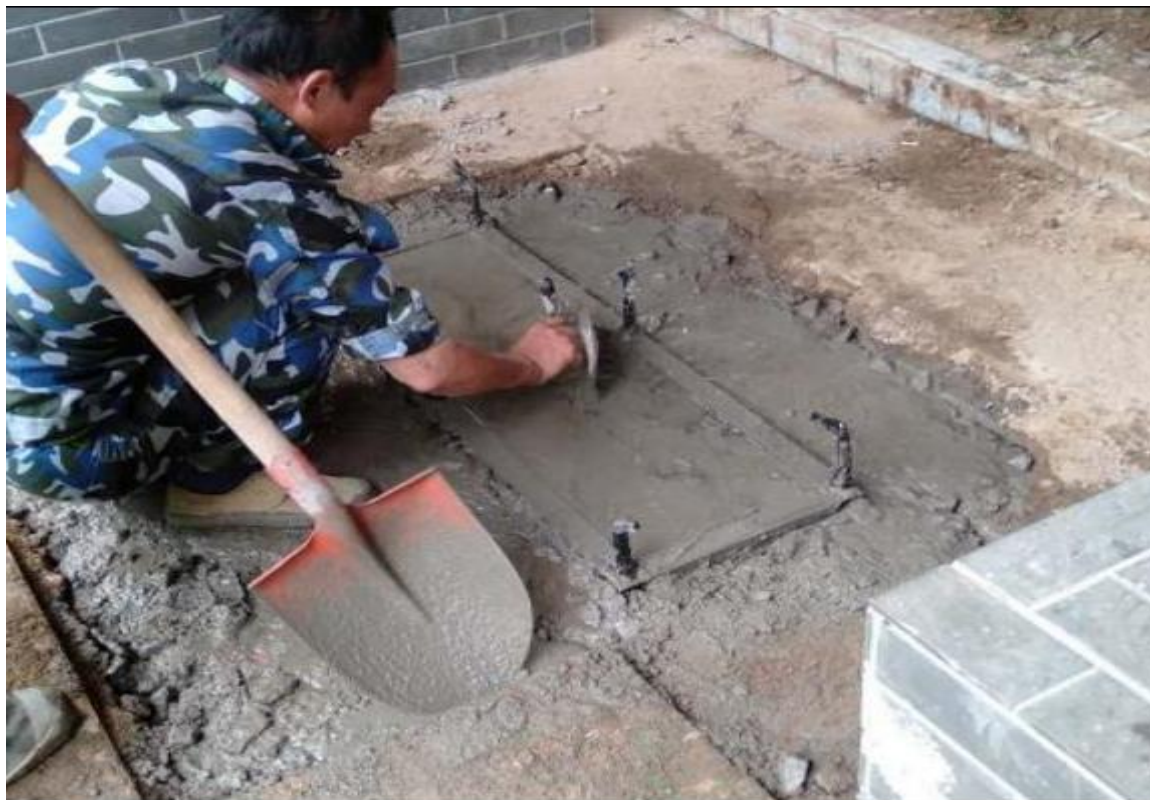
修整混凝土表面（示意图）
