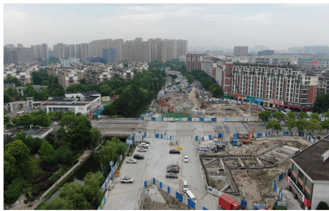
图 7 轨道交通地下支护已完成
