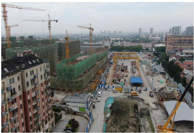
图 9 项目区北侧布置施工板房
