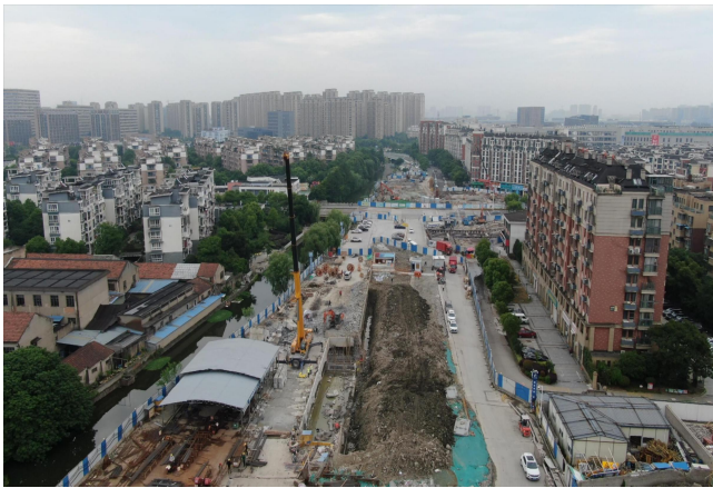
图 8 项目区内轨道交通现状堆土
