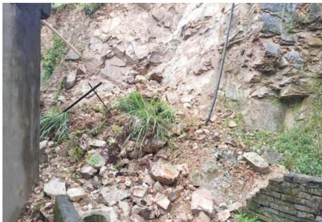
返回。”工作人员回忆道。7月28日晚8时左右,受台风“杜苏芮”强降雨影响,平田乡平田村52-53号屋后发生崩塌地质灾害,已发生崩塌规模约20立方米,潜在崩塌体约100立方米,崩积物对自来水管、水池等生活设施造成了破坏,房脚墙体局部破损。因人员转移及时,未造成人员伤亡。
