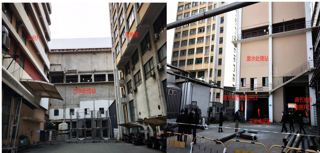
污水站地上建筑北视照片
