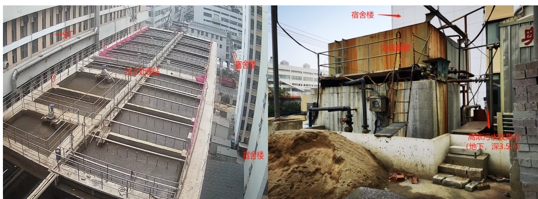
污水站顶层俯视照片
