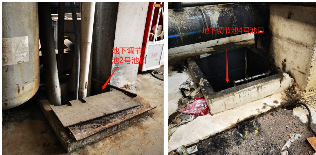
调节池气体溢出的池口
