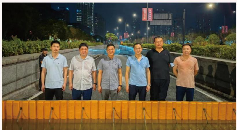
水动力全自动防洪闸无需电力驱动、无需人工值守，通过精准分析承载力和水浮力，设备在遇到雨水倒灌时，利用水的浮力就能帮助设备上的挡板“站”起来，实现全时段全自动挡水；随着水位下降，挡板也会随之下降，从而有效避免因突发汛情和夜间暴雨而导致的内涝事故。该设备的正式启用，有助于消除市民中心地下车库防洪安全隐患，提高市民中心在内涝灾害下的应急保障能力。下一步，市局将继续推进水动力全自动防洪闸在市民中心P1、P2停车库和其他地下建筑的安装建设，避免暴雨等灾害性天气对地下车库可能造成的破坏，确保市民中心地下空间人员、车辆和财产安全。
