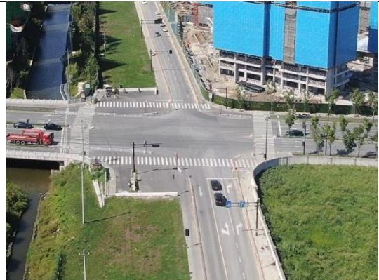
昙花庵路与明月桥路交叉口现状
