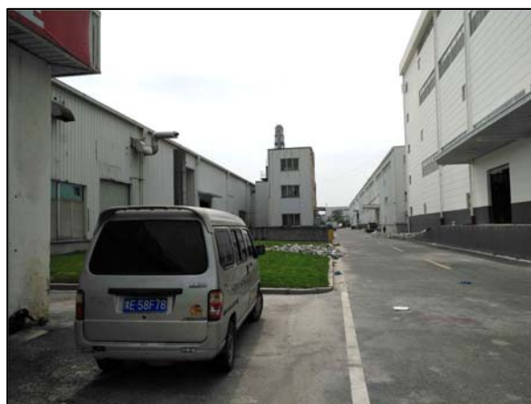
项目西侧1#仓库
