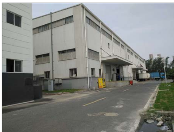
项目东侧2#仓库
