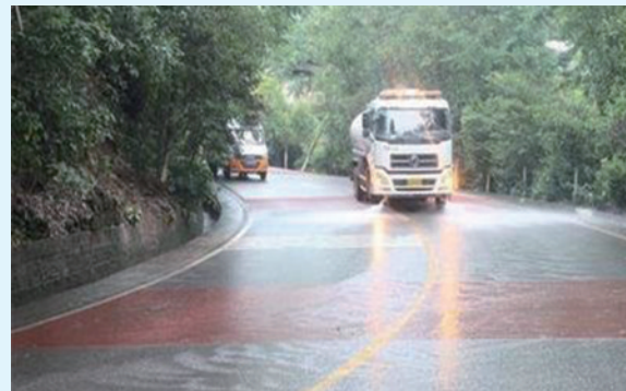
▲洒水车清洗路面
