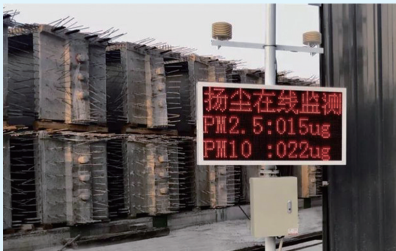
▲扬尘监测系统
