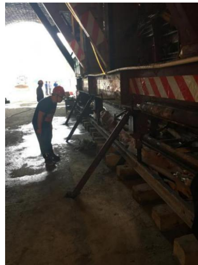
f) 丝杆支撑在仰拱调平层
