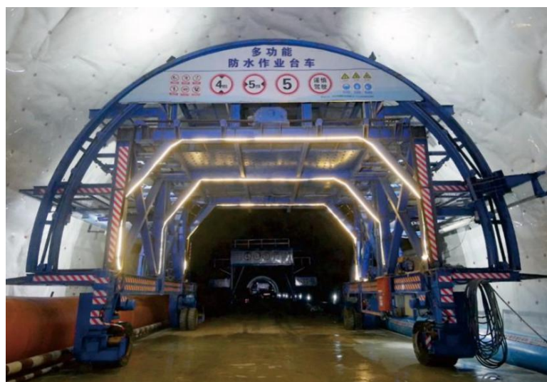
图 E.19 防水卷材作业台车
