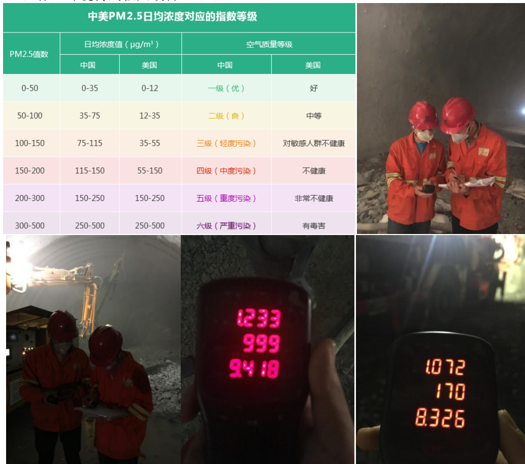
图 E. 12 采用湿喷机械手施工 PM2.5 检测
