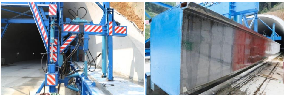
图 E.28 电缆沟槽台车
