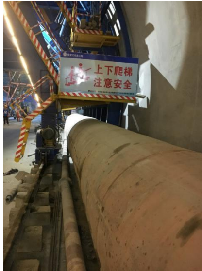
c) 风带过二衬台车无挤压
