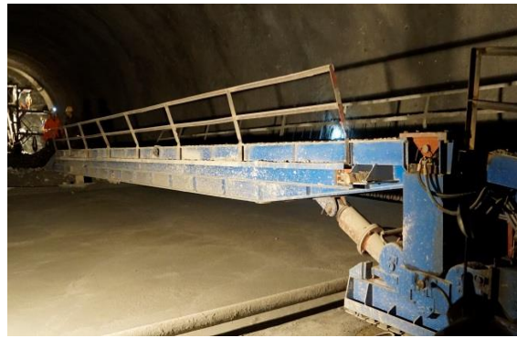
b) 自行式移动栈桥
