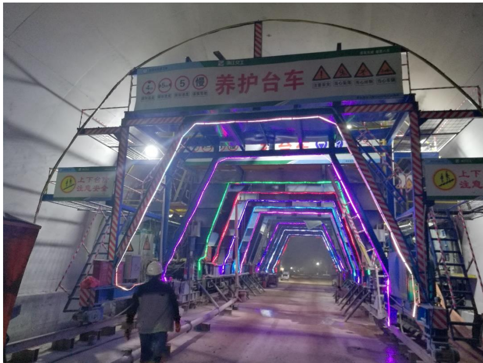
图 D. 20 全自动轨道式二衬养护台车
