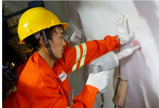
图 E.22 防水板热熔焊接
