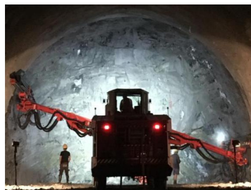
图 E.3 多臂凿岩机钻孔
