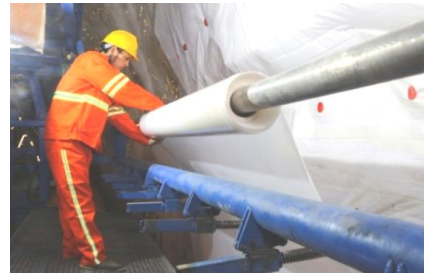
图 14 防水板铺设示意图
