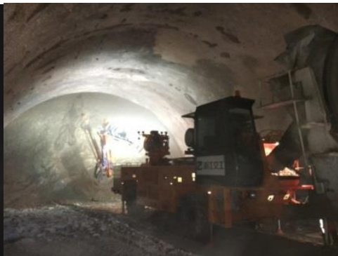
图 E.9 湿喷机械手喷砼
