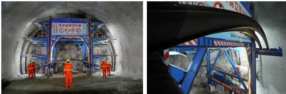
图 E. 17 拱架台车提升拱架
