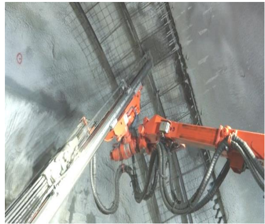
b) 锚杆钻孔施工示图
