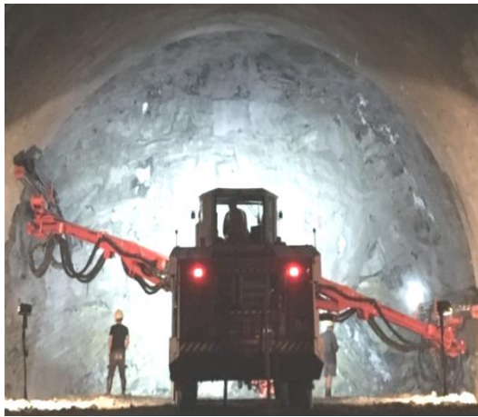
a) 炮眼钻孔施工示图
