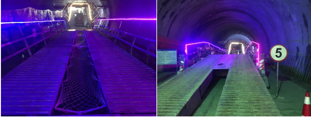
图 E. 13 自行式移动栈桥
