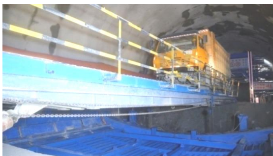
图 10 自行式移动栈桥就位示图
