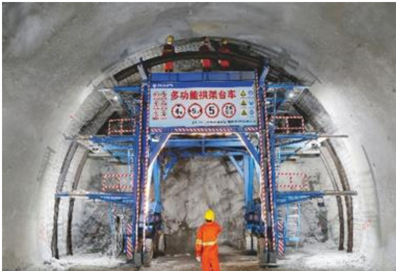
图 E. 16 拱架台车
