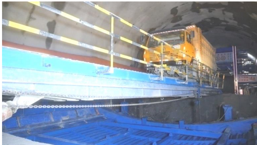
图 E. 15 自行式移动栈桥的车辆通行效果
