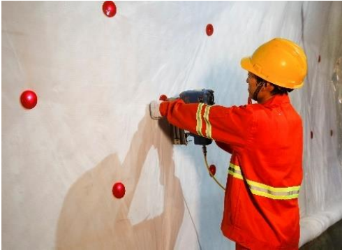
图 E.21 热熔垫片安装
