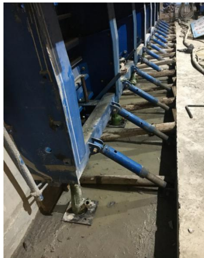
e) 丝杆支撑在电缆沟槽
