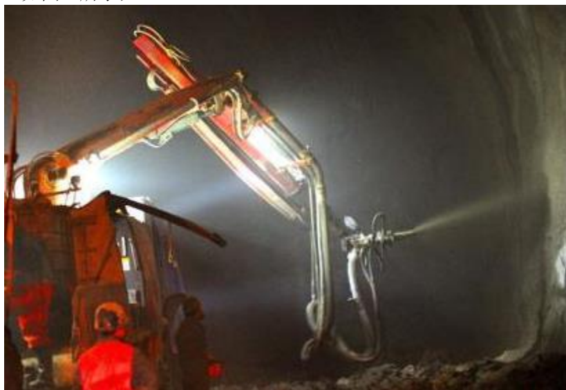
图 6 初喷示意图
