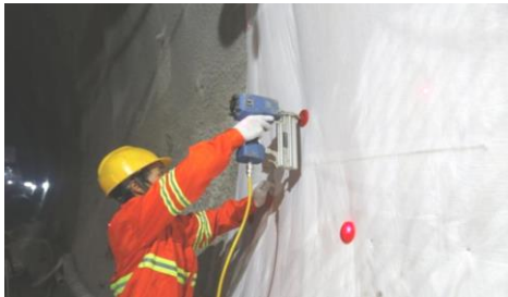
图 13 红外线激光定位射钉热熔垫片示意图
