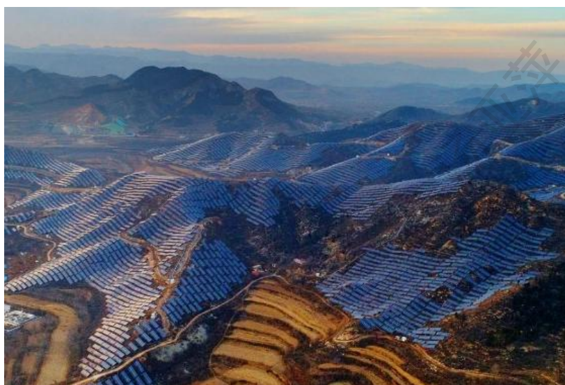
太阳能供电装置
