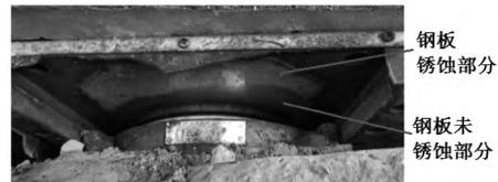
图5 盆式支座部分钢板锈蚀
