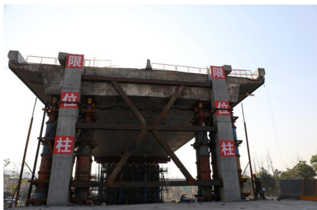
图C.14 7#桥台位置限位装置施工
