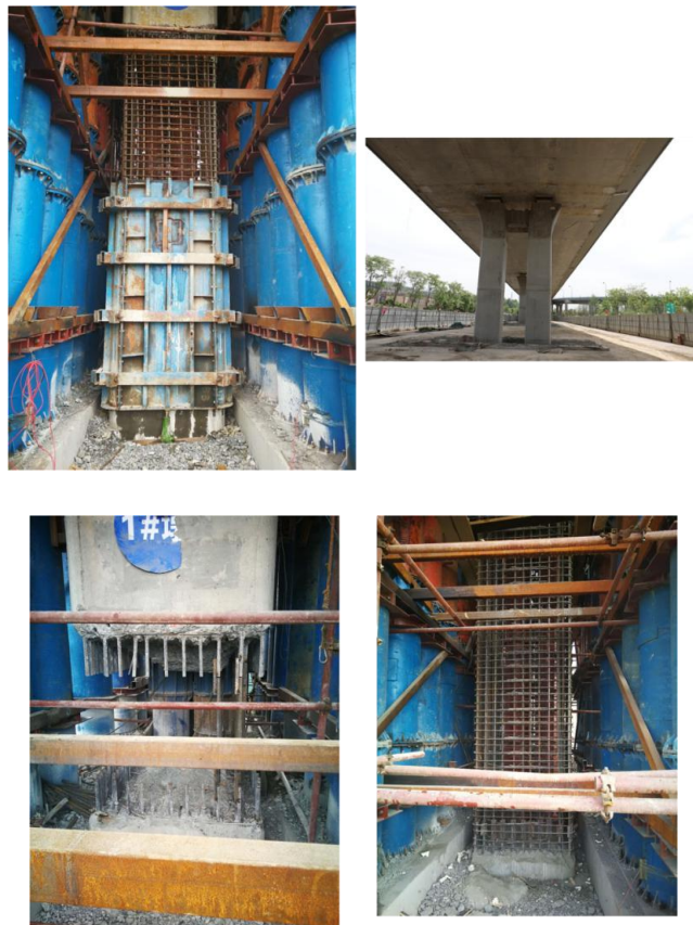
图C.20 桥墩顶升改造施工
