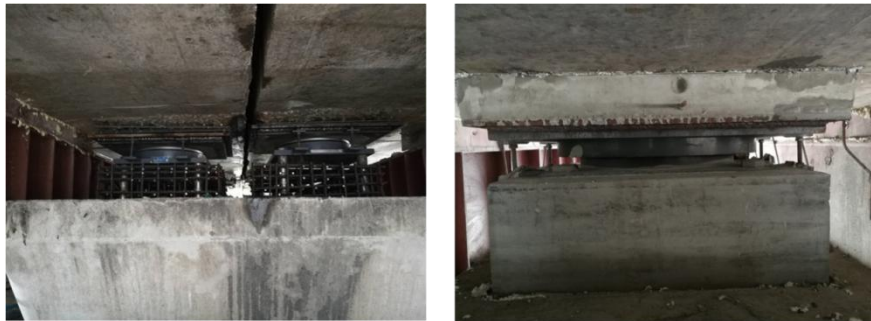
图C.22 支座垫石改造施工
