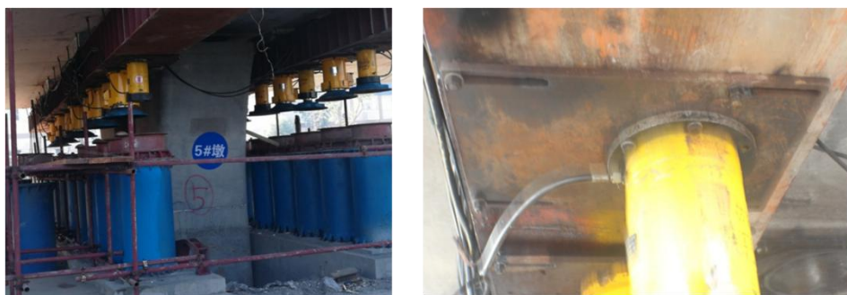
图C.15 千斤顶安装
