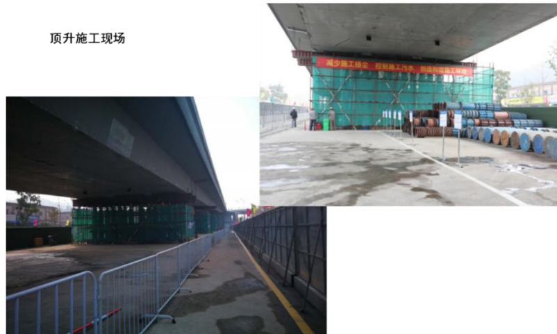
图 C.9 顶升施工现场
