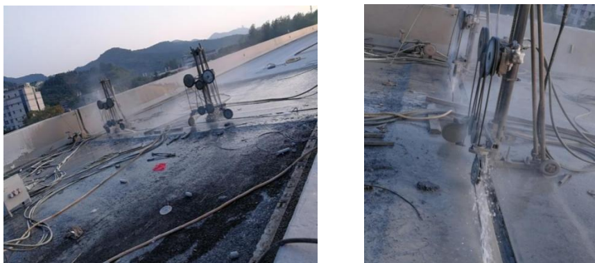
图C.17 0#墩伸缩缝箱梁端部切割
