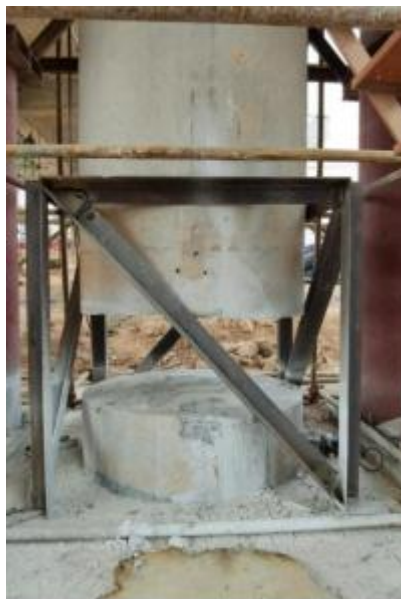
图 18 断柱顶升桥墩限位示例
