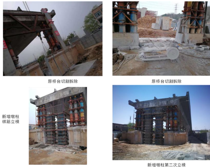
图C.21 桥台改造施工
