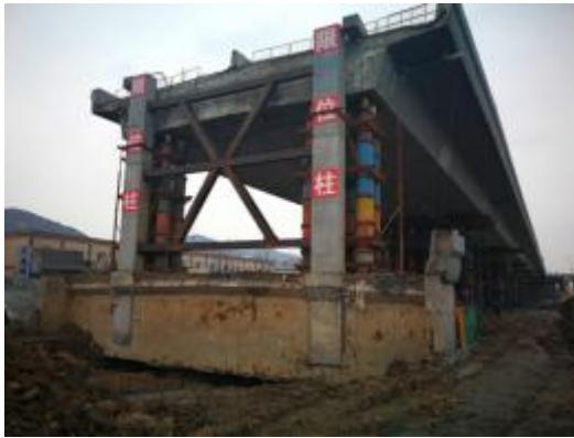
图 14 桥台位置限位结构示例
