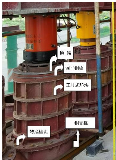
图 11 顶升支撑体系应用示例
