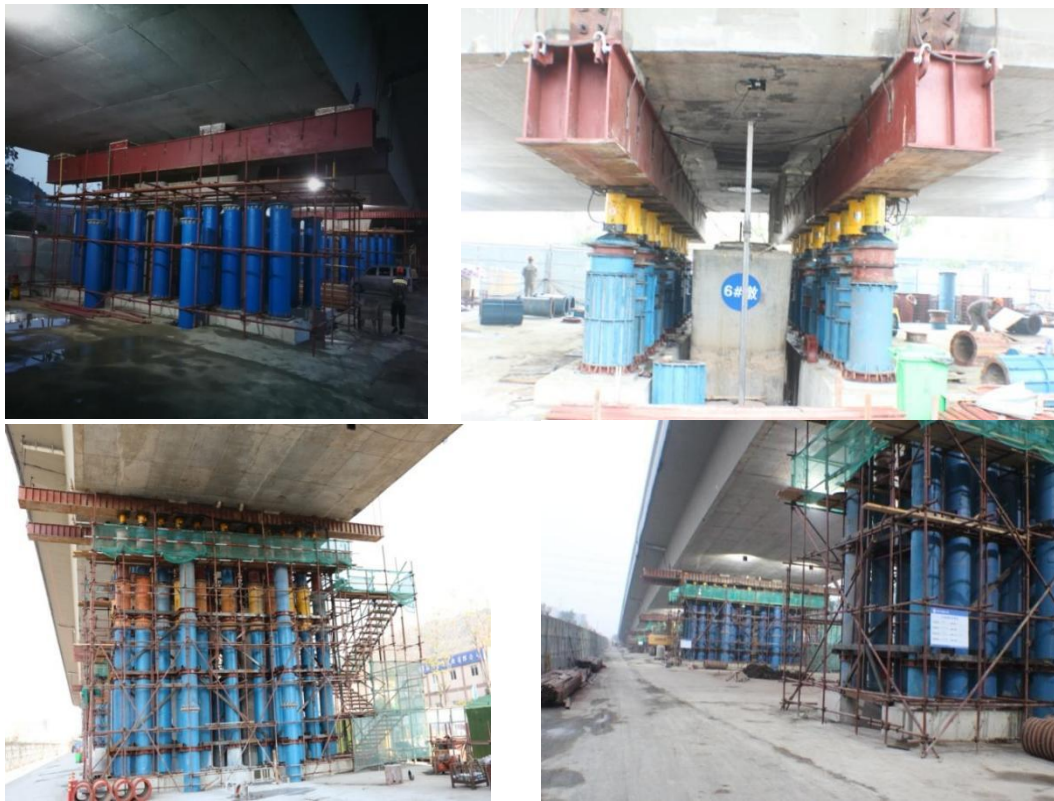
图 C.11 钢支撑施工
