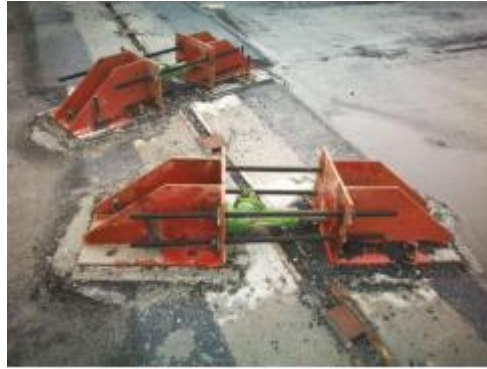
图 16 伸缩缝位置限位示例
