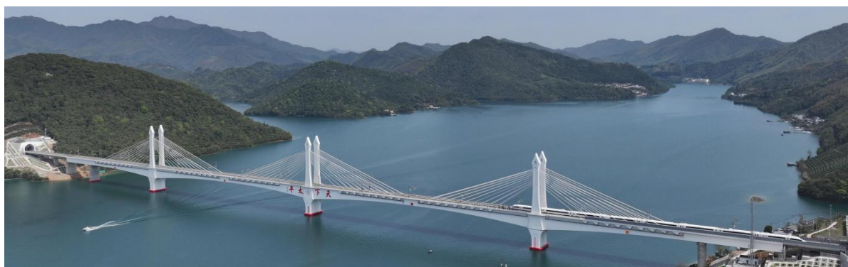
池黄高铁重点工程——太平湖特大桥
