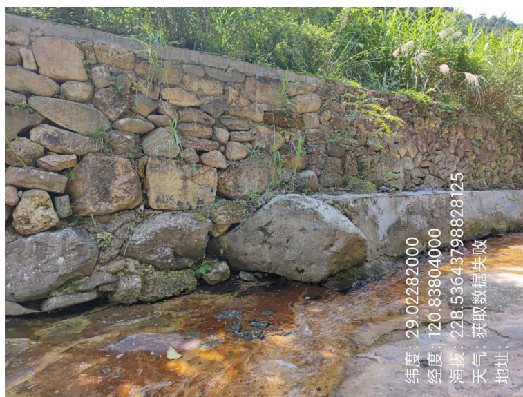
图 3.2-2 护岸加固段代表性现状情况
