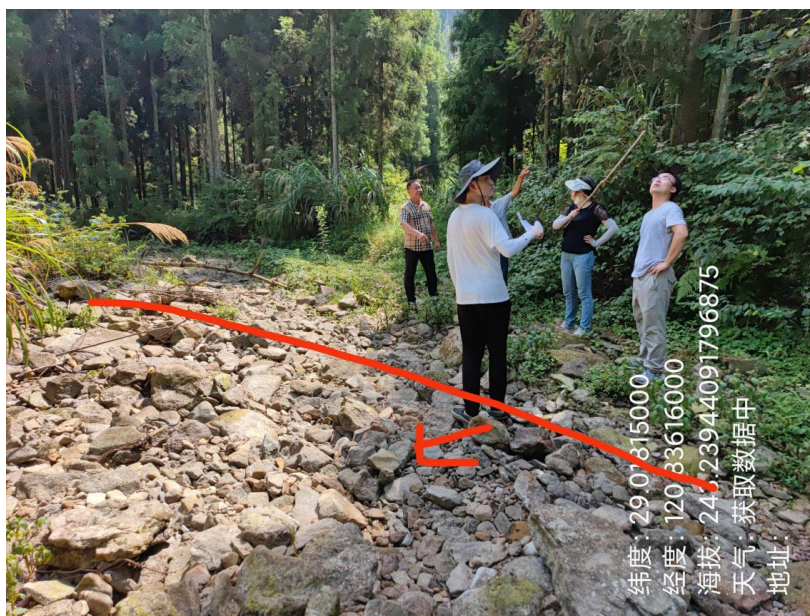
图 3.2-3 护岸修复段代表性现状情况
