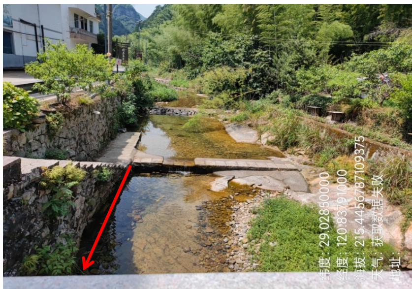
图 3.2-1 堤防加固段代表性现状情况
