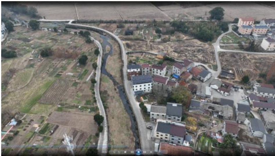
图 3.2-10 乌岩溪河道下园殿村段
