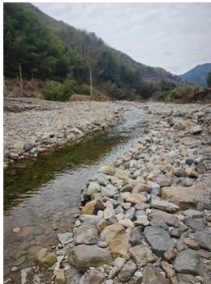
图 4.3-8 大同溪河道现状
