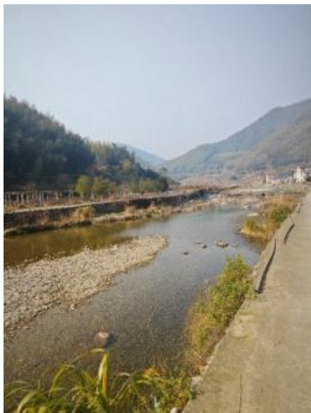
图 4.3-7 大同溪河道现状
