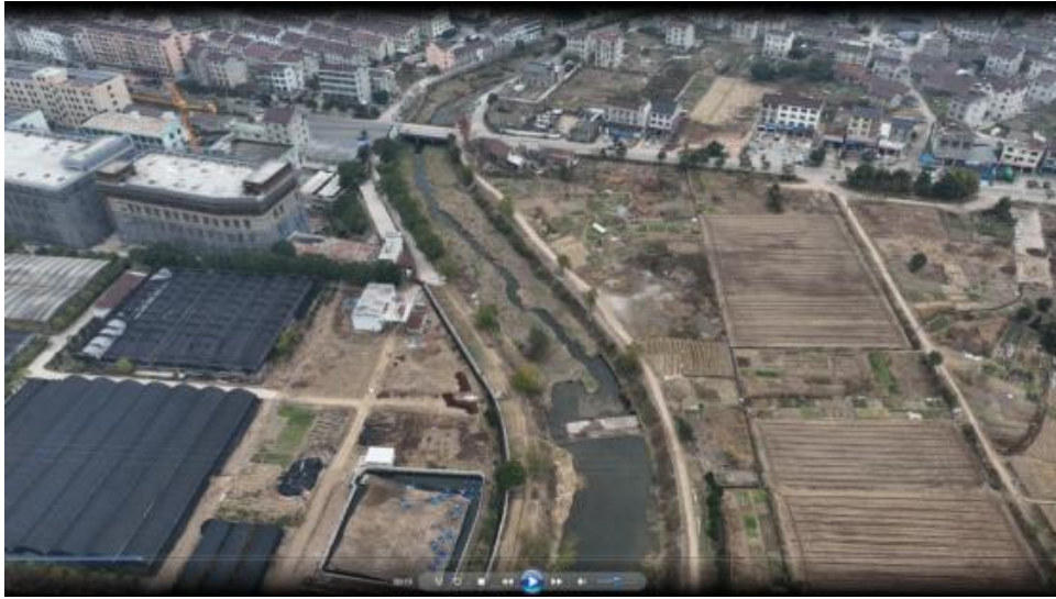
图 3.1-9 乌岩溪河道下园殿村段
