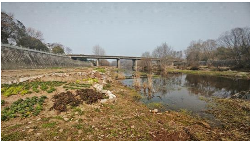
图 4.3-9 大同溪河道现状
