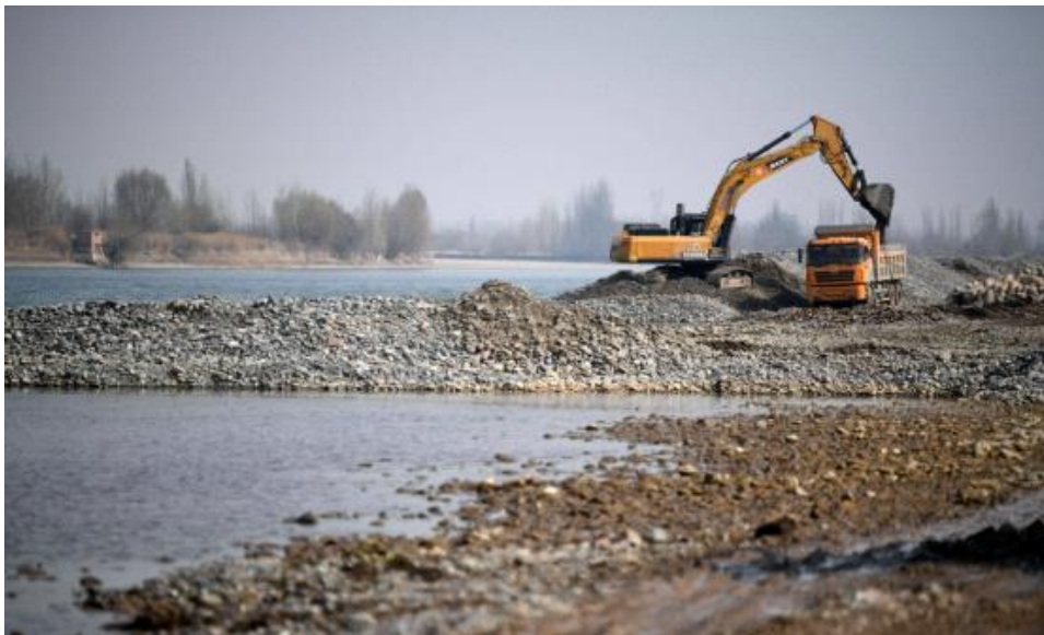
挖掘机疏浚方式
