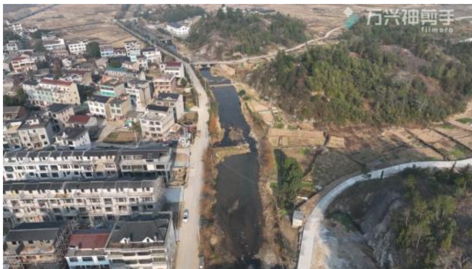
图 3.1-4 苍南溪河道中部堰坝处
