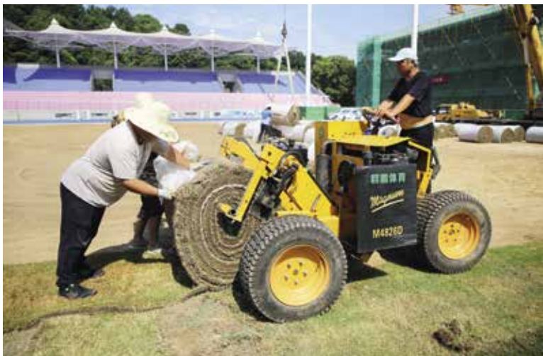
2021年6月下旬,鉴湖足球场扩建工程进入草皮种植阶段,施工人员用专用车辆在辅种高档草皮(陶文强 摄)
