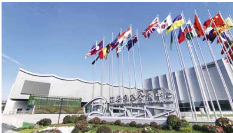
2021年10月,绍兴国际会展中心一期B区工程全面建成
