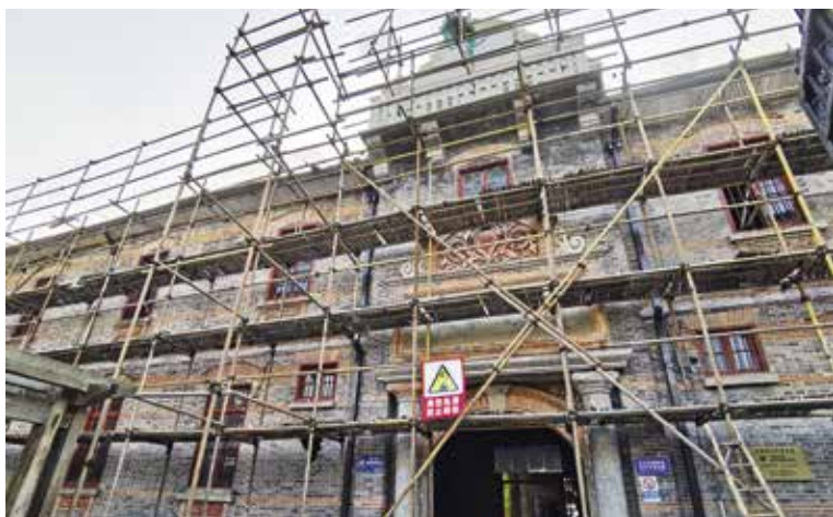
2021 年,浙江省文物保护单位善庆学校旧址修缮现场 (孟青青 摄)
