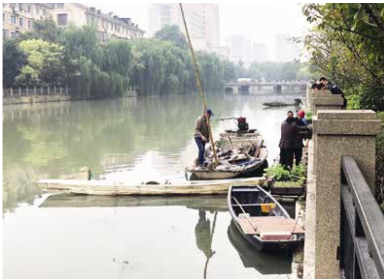
2021年,柯桥区水政执法拆除现场 (区农业农村局 提供)
