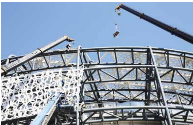
2021年11月,建筑工人对羊山攀岩馆表皮进行施工(陶文强 摄)
