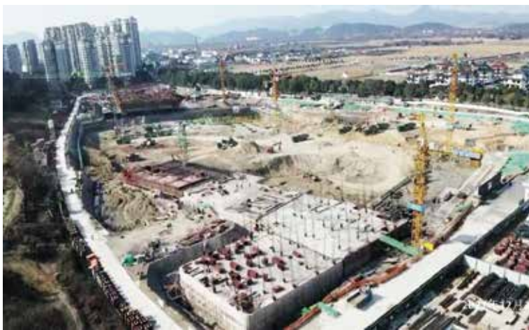
2021年3月底,绍兴二院兰亭院区(康复医院)项目进场施工
