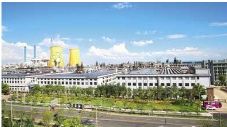
2021 年,柯桥经济技术开发区浙能热电及周边工业一角
