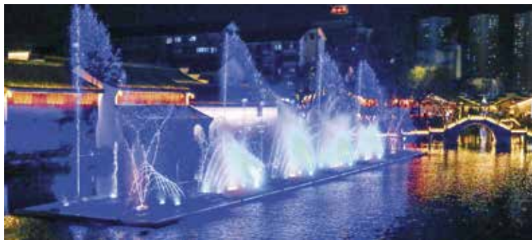
2021 年 10 月 23 日, 柯桥古镇北入口广场水秀项目工程完工
