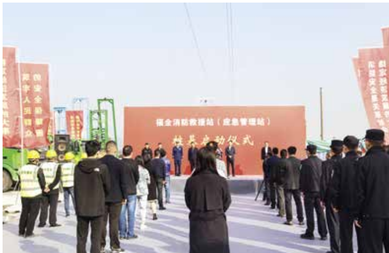
2021年10月23日,福全街道举行消防救援站(应急管理站)桩基启动仪式
