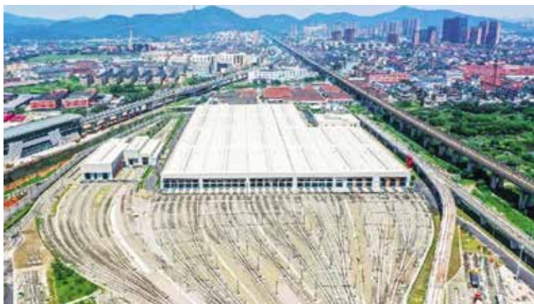
2021 年,绍兴轨道交通 1 号线(柯桥段)车辆基地
