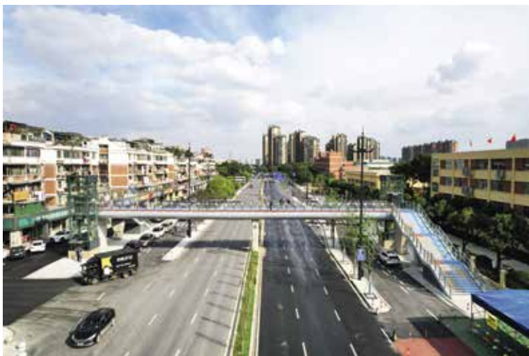
2021 年 12 月,兴越路(越州大道一区界段)改造升级工程完工 (区建设集团 提供)
