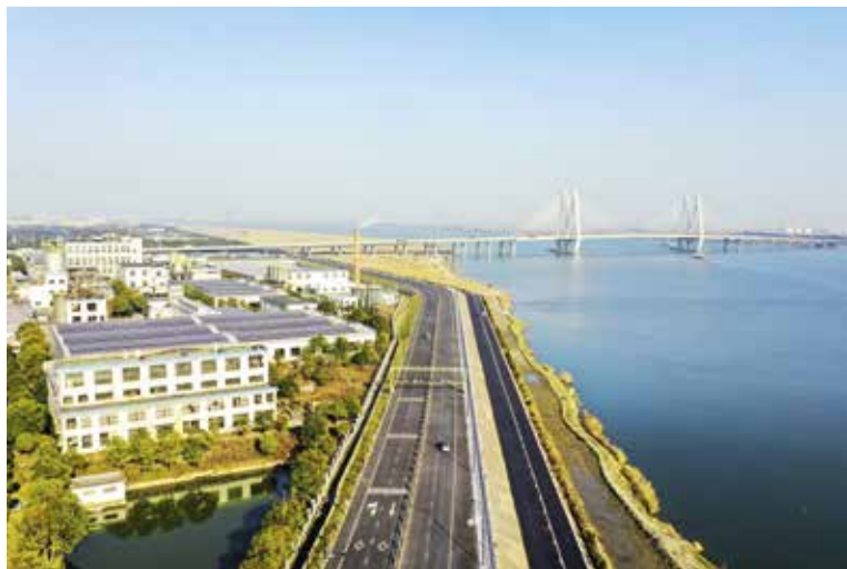
2021 年 12 月 30 日,曹娥江综合整治工程(柯桥段)堤顶道路全线试通车运行 (赵 炜 摄)
