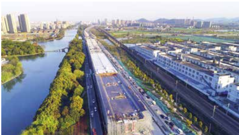
2021 年,杭州中环纺城大道高架段施工现场
