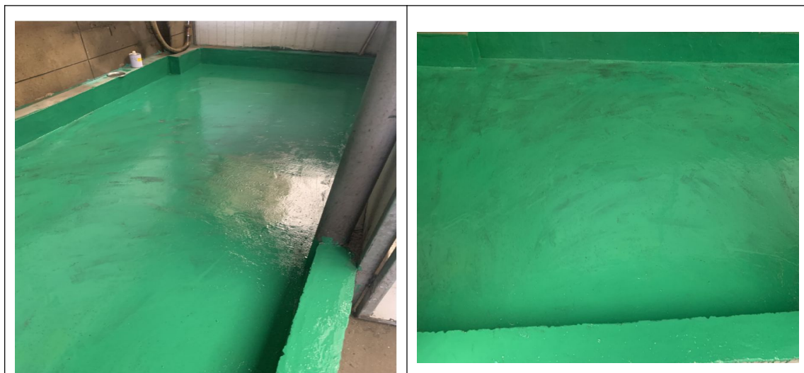
图 3.1-1 整改后的现有危废仓库照片
