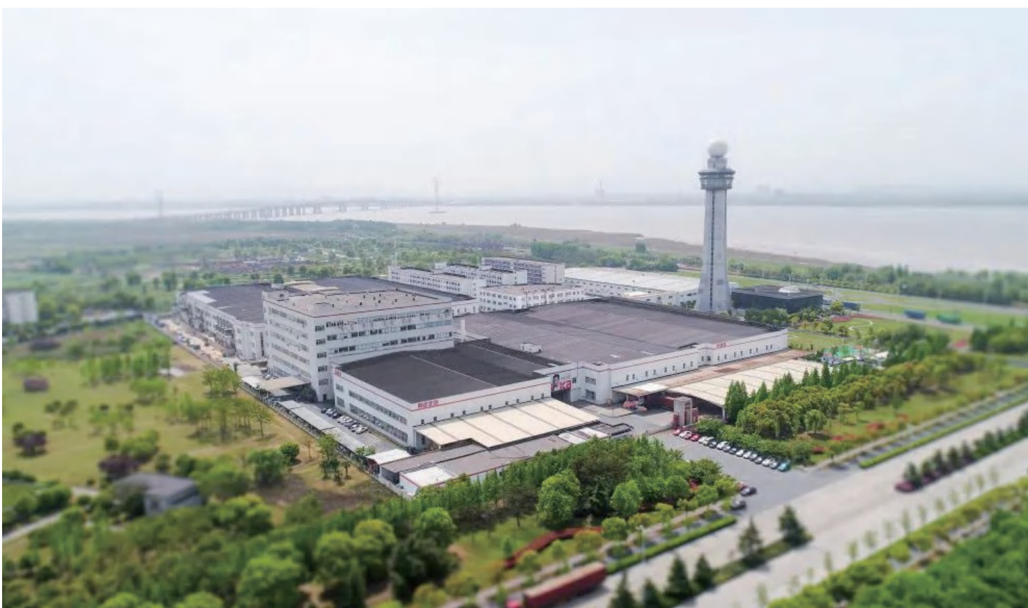
钱塘供电公司大有钱塘分部
