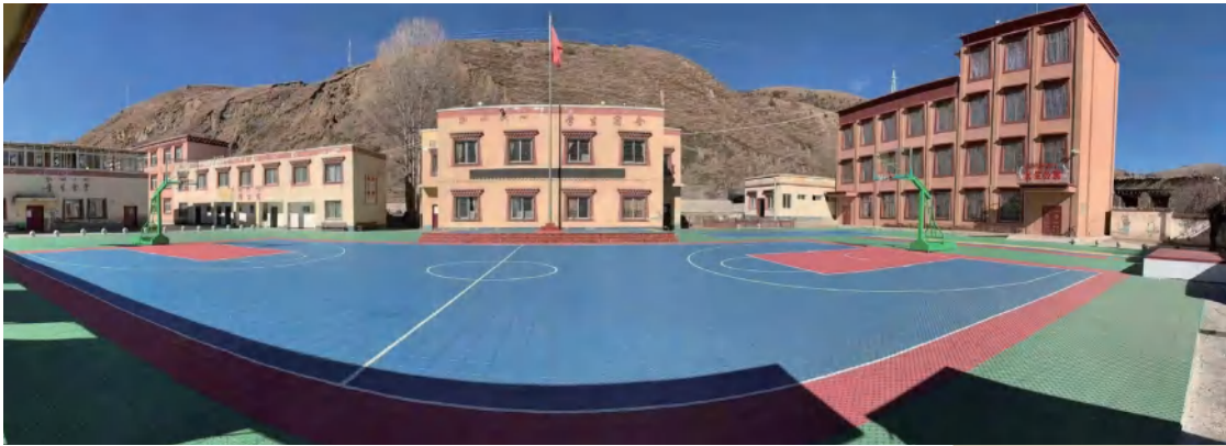
2021 年 11 月，钱塘区援建的 3 个学校操场提升项目全面投用
