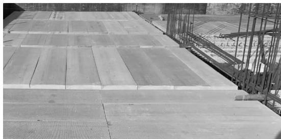
图 4-4 楼板保温体系临近混凝土层面
