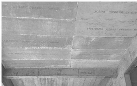
图 4-5 楼板保温体系施工后底面
