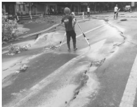
图 1-2 基坑周边道路沉降和地下管线受损
