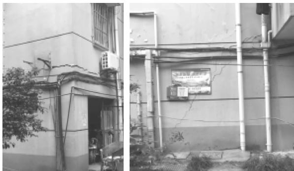
图 1-1 基坑周边建筑物沉降开裂
