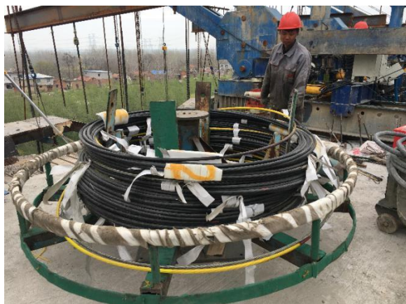
图 5.2.1 钢绞线索盘及下料完成钢绞线
