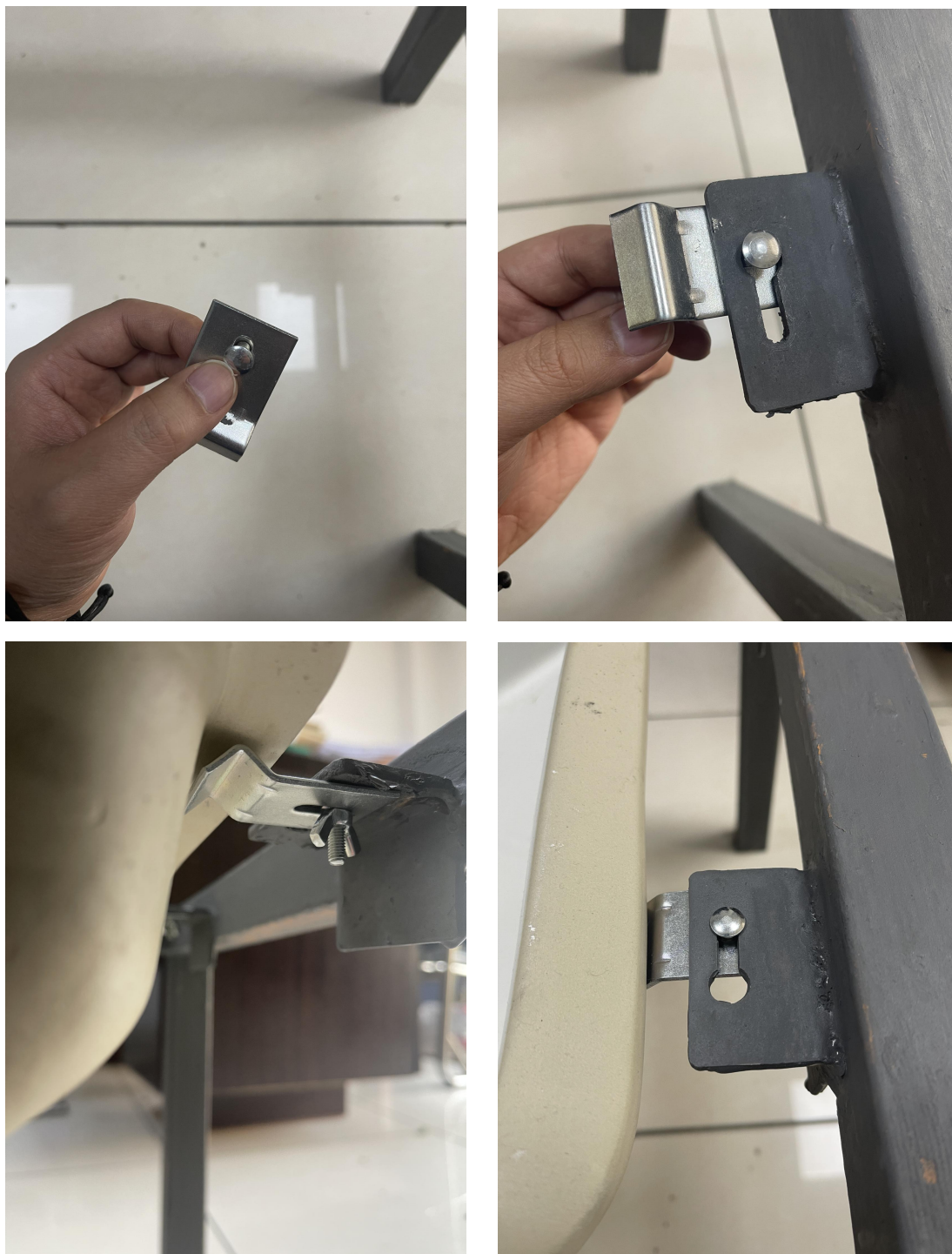
图 5.2.4 台下盆安装流程
