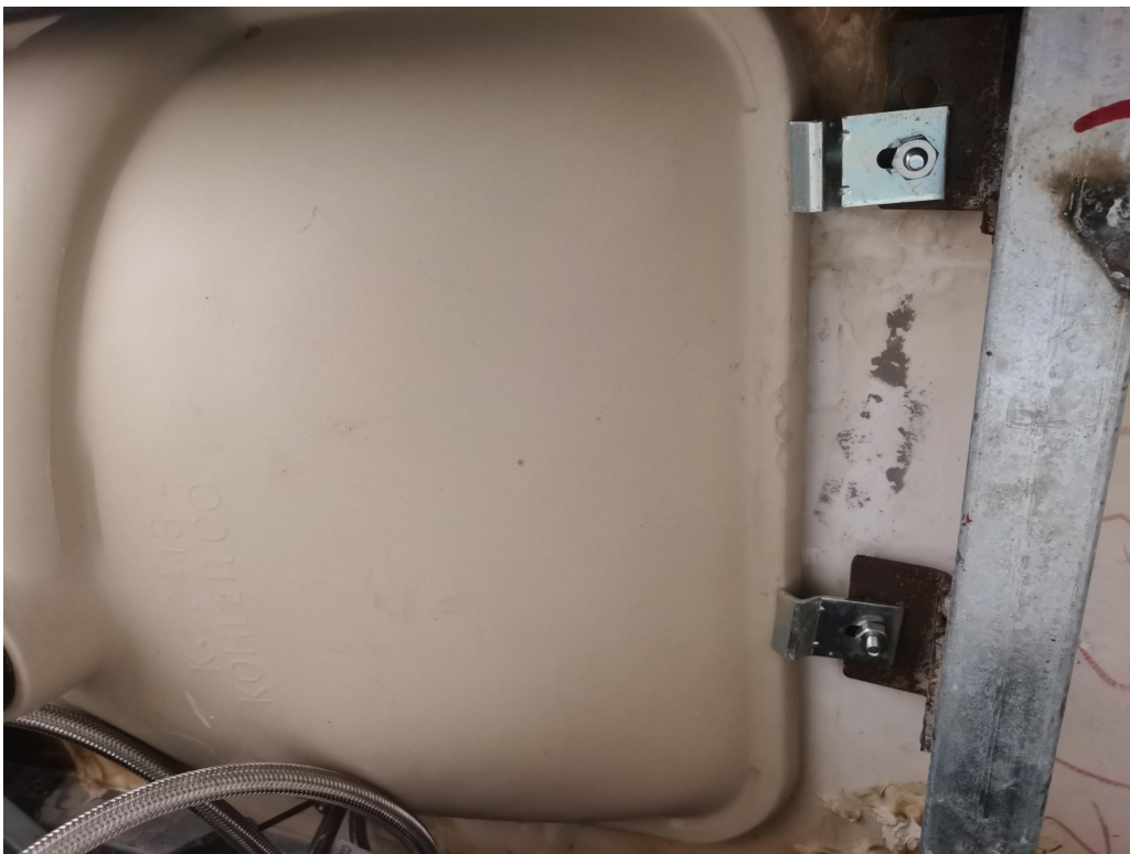
图 5.2.5 台下盆固定装置应用照片
