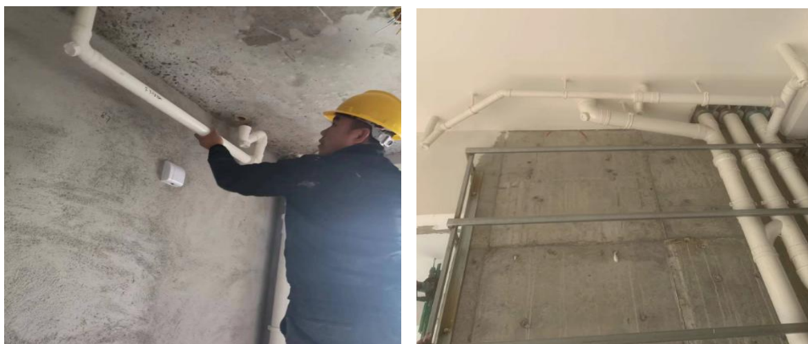
图5.2.7卫生间管道装配安装
