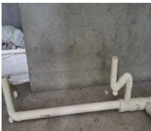
图5.2.6 管道试拼装
