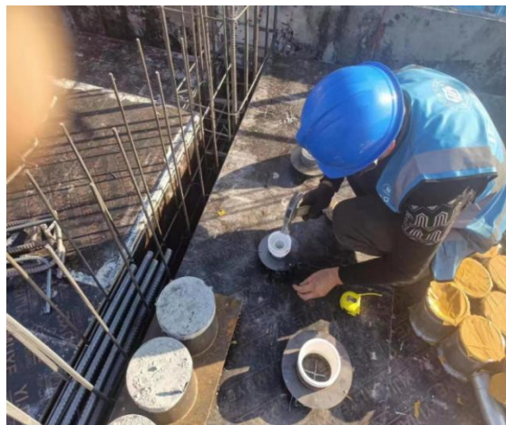
图5.2.4-2预埋套管固定
