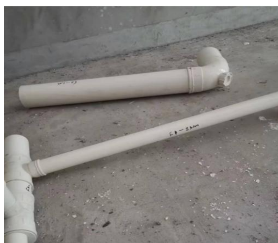
图5.2.6 管道试拼装
