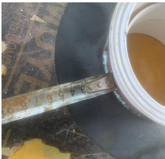
图5.2.3-1 预埋套管止水翼环
