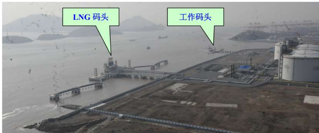
图 3.1-4 现有工程码头工程现场情况
