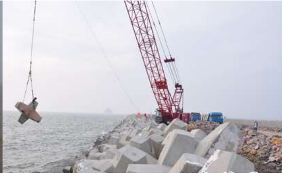
图 4.3-20 护面块体吊安
