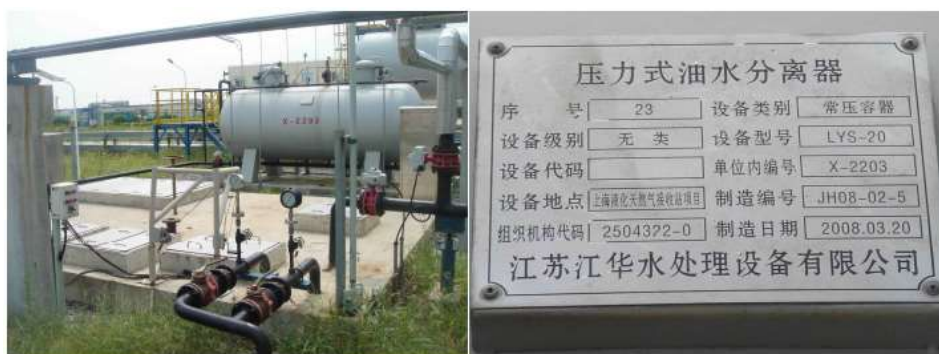
图 3.3-2 现有工程接收站生产废水处理系统
