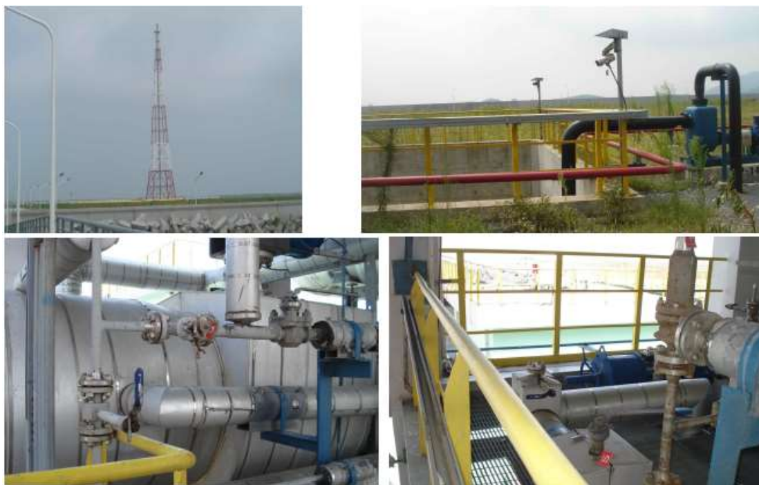
图 3.4-1 现有工程接收站火炬、集液池、紧急截断阀
