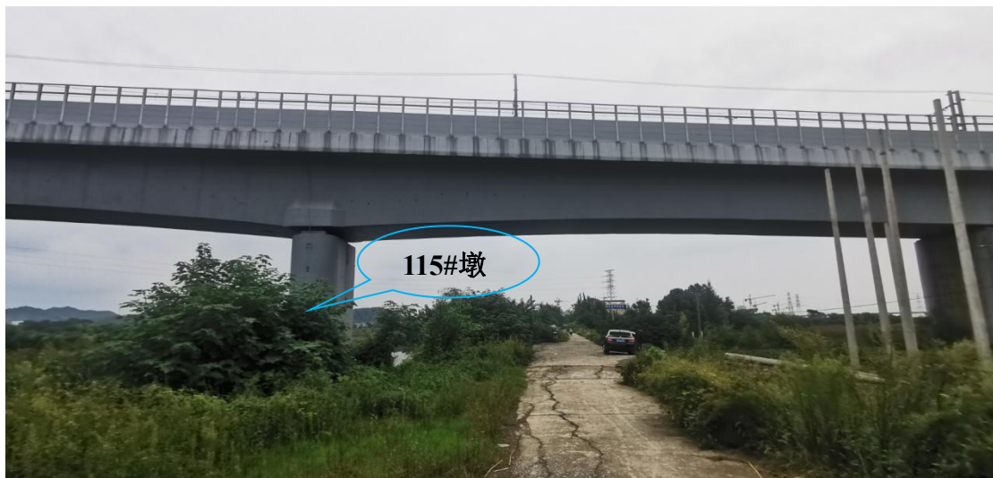
图 1.8 杭州地铁 16 号线青山湖科技城站～南峰站高架区间
