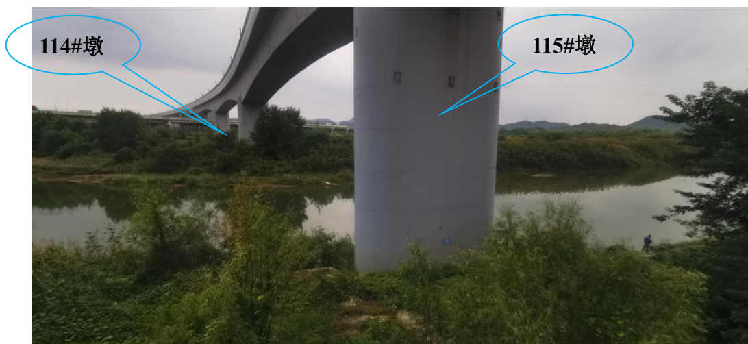
图 1.10 (60+100+125+100+60) 连续钢构桥梁现场照片 (114#、115#桥墩)
