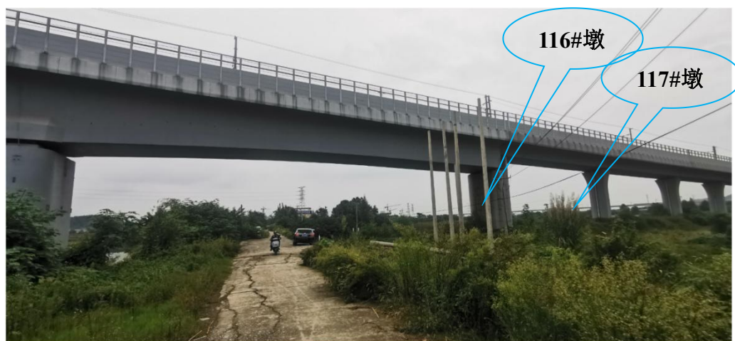
图 1.11 (60+100+125+100+60) 连续钢构桥梁现场照片 (116#、117#桥墩)
