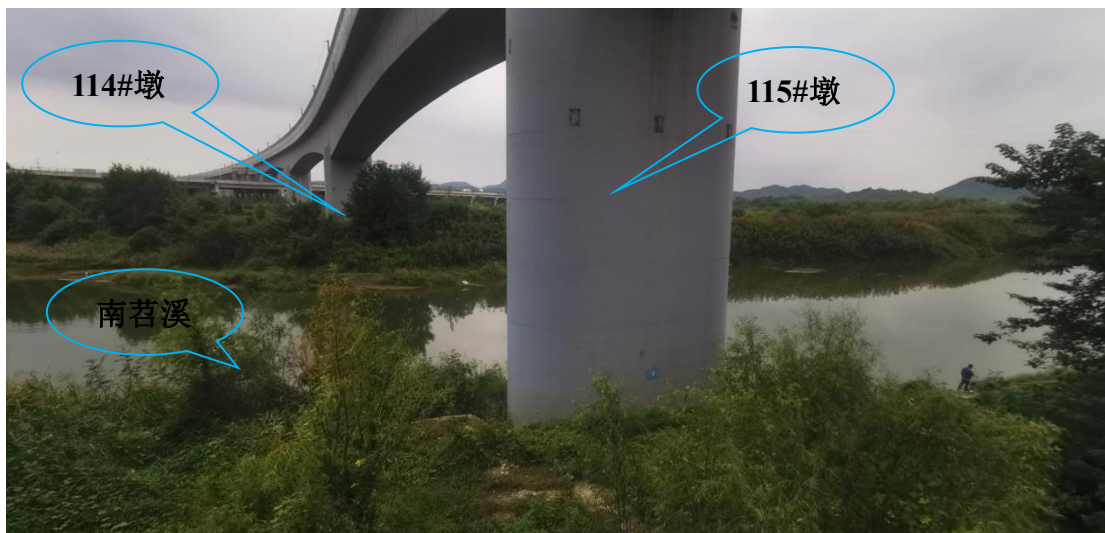
图 3.1 青山湖科技城站~南峰站高架区间 114#、115#墩现状照片
