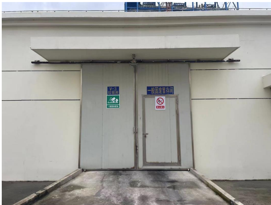
图 3.6.3-2 一般固废暂存间
