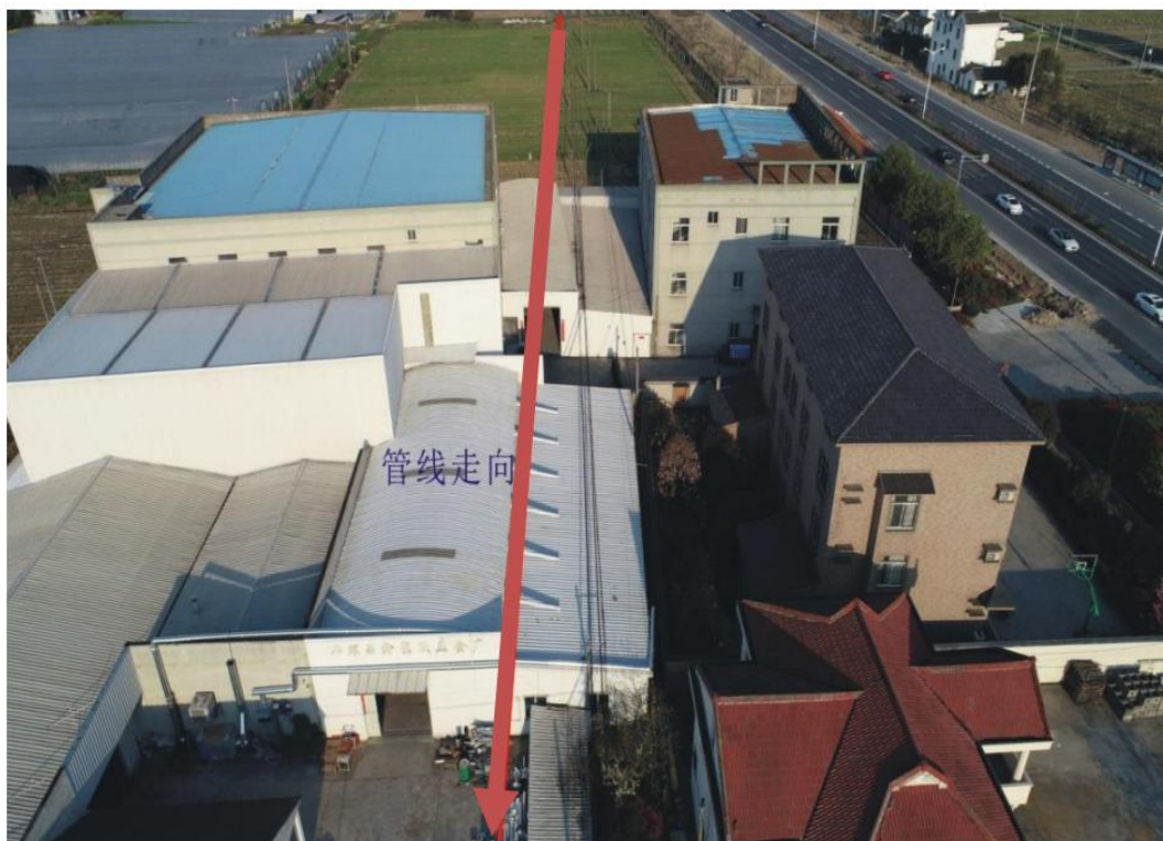
图 1-4 甬宁线白石段 173#-173#+70m 管道现状路线照片
