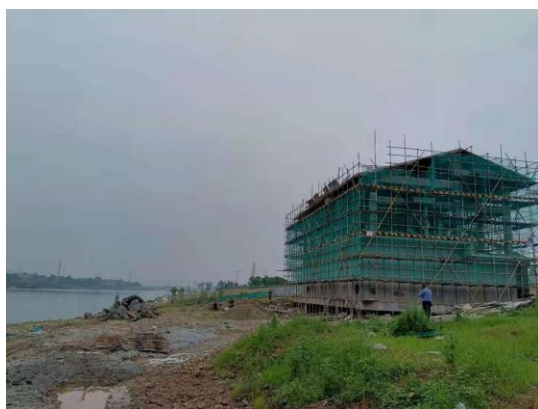
取水泵房建设现场
