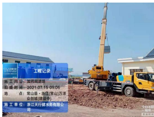
新水厂建设现场
