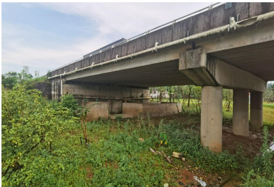
图 4.3-1 湖澄大桥桥面径流收集系统
