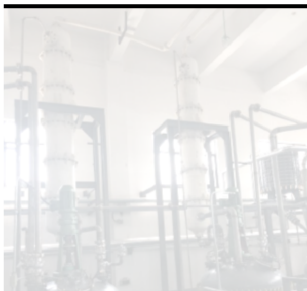
图 3.1-8 氨气处理设施照片
