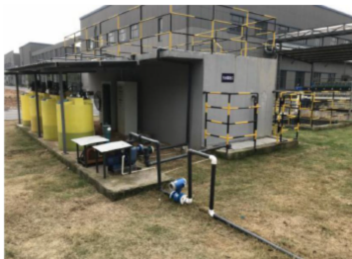
图 3.1-4 现有厂区污水站照片
