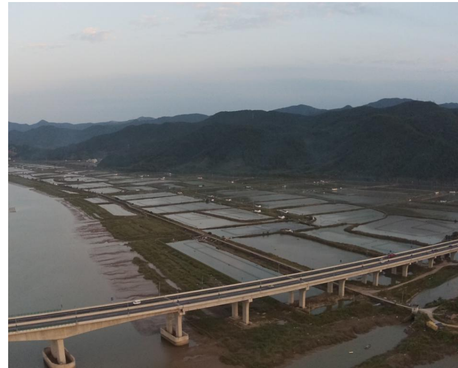
图4.5-3 海游港特大桥右岸河岸线
