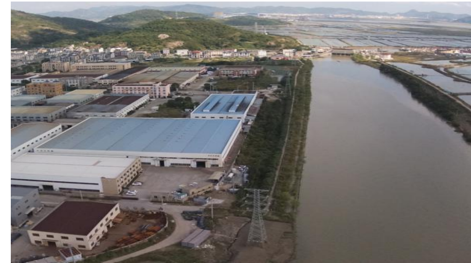
图3.1-8 洞港工业园区段河道情况
