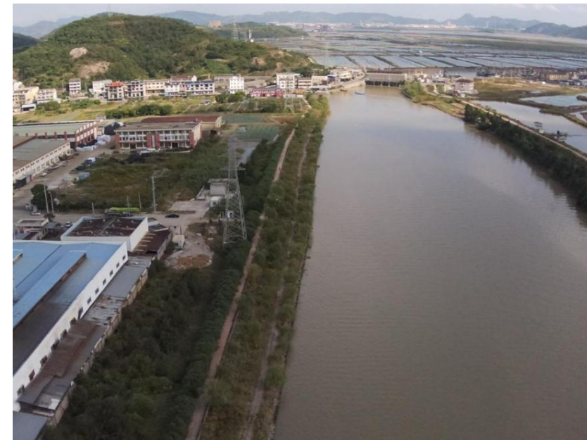
图4.5-6 洞港工业园区段河岸线
