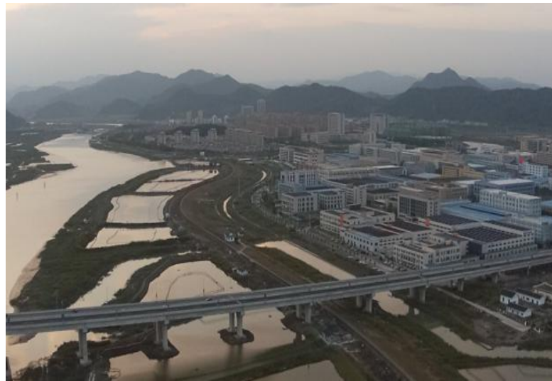
图3.1-4 滨海新城段河道情况
